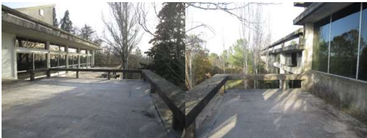
Figura 5 - Fachada do piso -1 e cobertura do piso -2, Portalegre, 2018 (Fotografia da autora)
