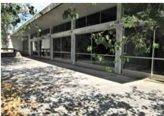
Figura 23 - Existente - Fachada Noroeste Clube de Ténis de Portalegre - Sala de Eventos, Portalegre, 2018. (Fotografia da Autora)
