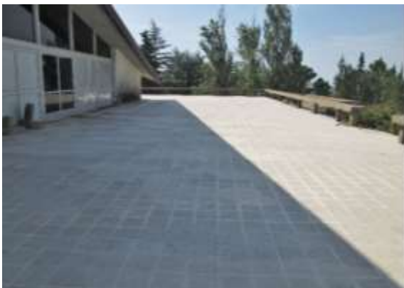
Figura 19 - Existente - Fachada Nordeste Clube de Ténis de Portalegre, Portalegre, 2018. (Fotografia da
