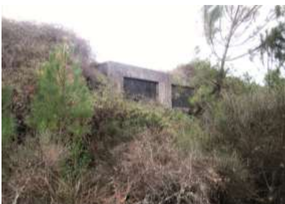
Figura 33 - Existente, Galeria de Saída dos Túneis, Clube de Ténis de Portalegre, Portalegre, 2018. (Fotografia da Autora)
