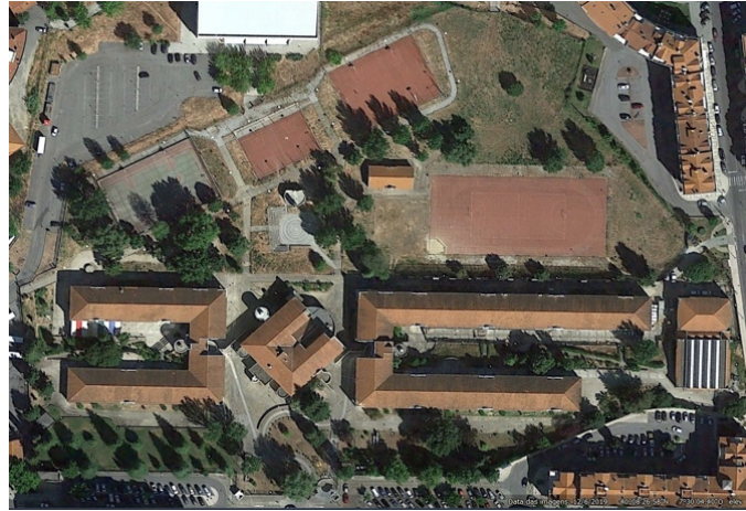
Figura 1. Vista aérea da escola
