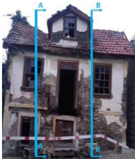
a) Construção C1
