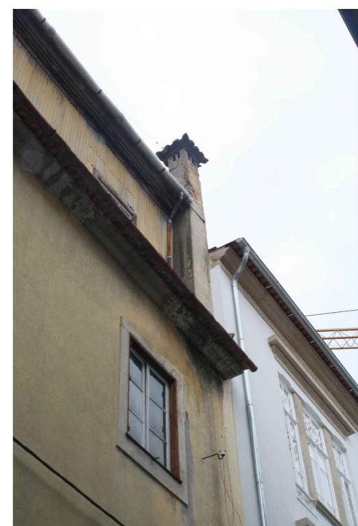
Pormenor da Fachada Posterior
