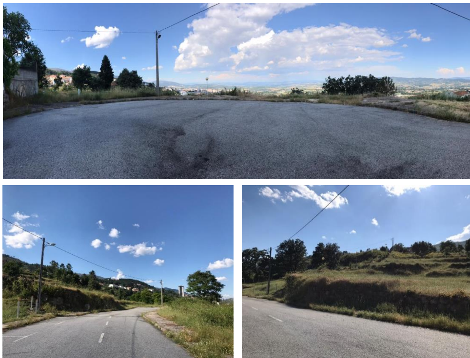
Figura 24: Acessos existentes – Urbanização Ribeiro Negro.
