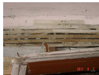
c) Revestimento de viga
