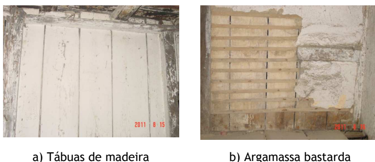
Figura 3.36 - Revestimento interior diferenciado de paredes de tabique
