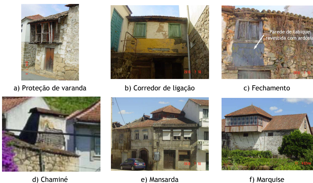
Figura 3.19 - Outras funções dos elementos de tabique
