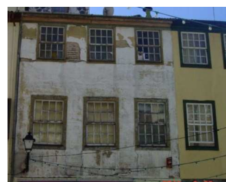
c) Argamassa à base de cal
