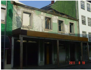
c) Obras de demolição
