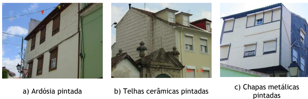
Figura 3.31 - Revestimento exterior pintado
