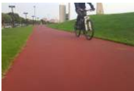
Figura 64- Pavimento em neoasfalto
