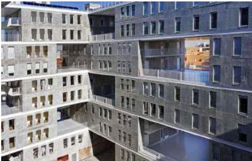
Figura 42- Edifício Celosia em Sanchinarro, Madrid
