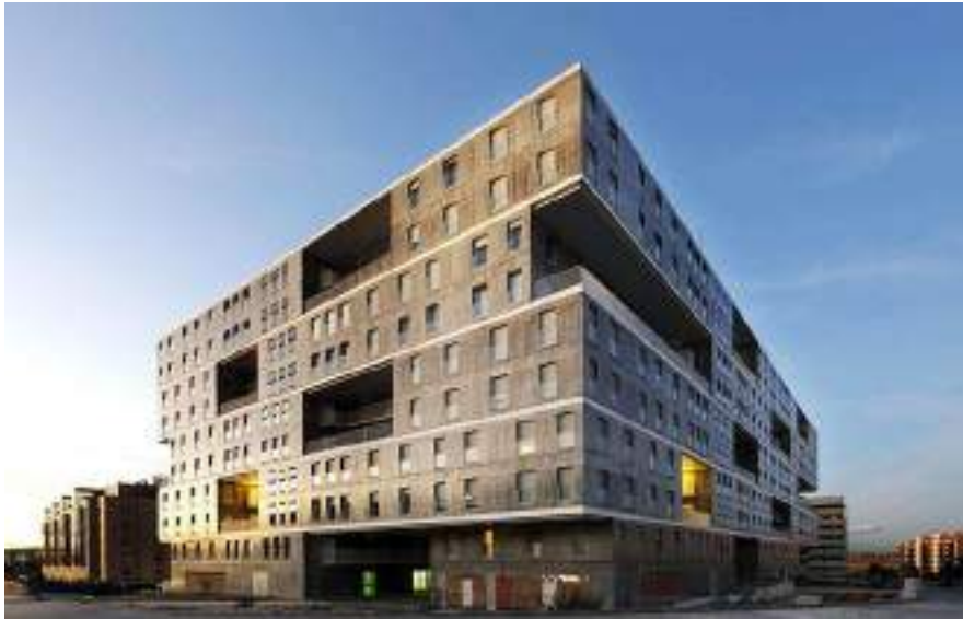
Figura 41- Edifício Celosia em Sanchinarro, Madrid
