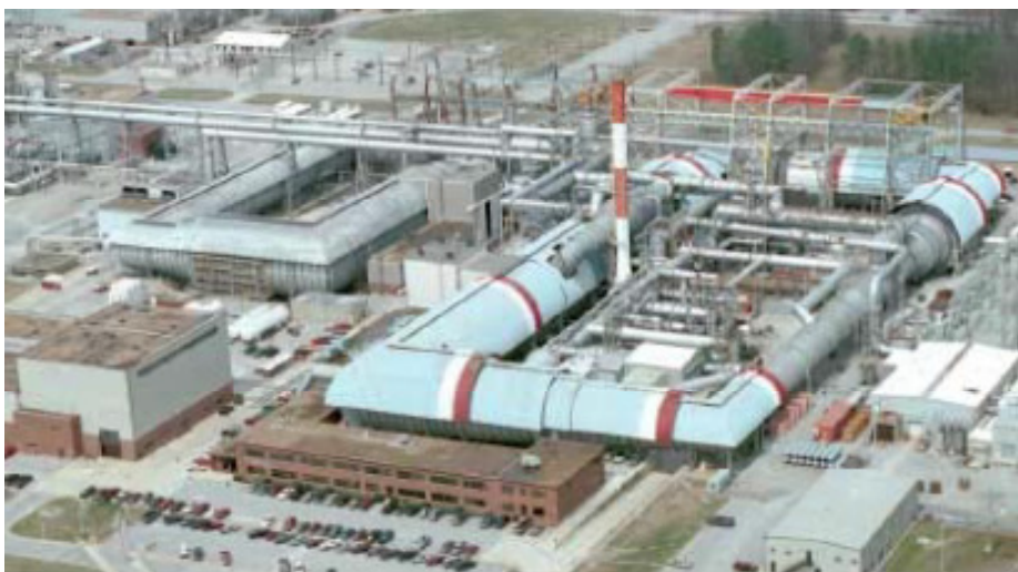
Figura 3.41 - Instalações do Arnold Engineering Development Center (Fonte: http://www.loc.gov/rr/frd/pdf-files/Western_Hemisphere_Wind_Tunnels.pdf , pag 120.)
