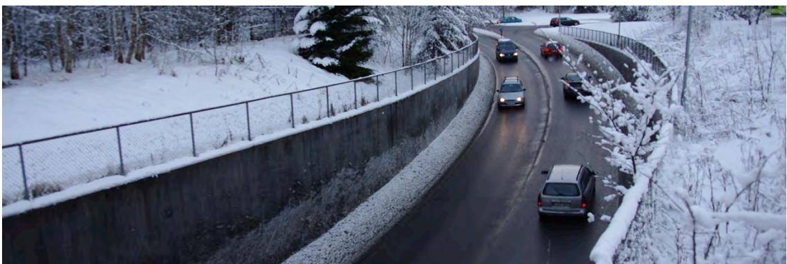
Fig. 54 - Rua Drobakveien, no topo norte do terreno.
