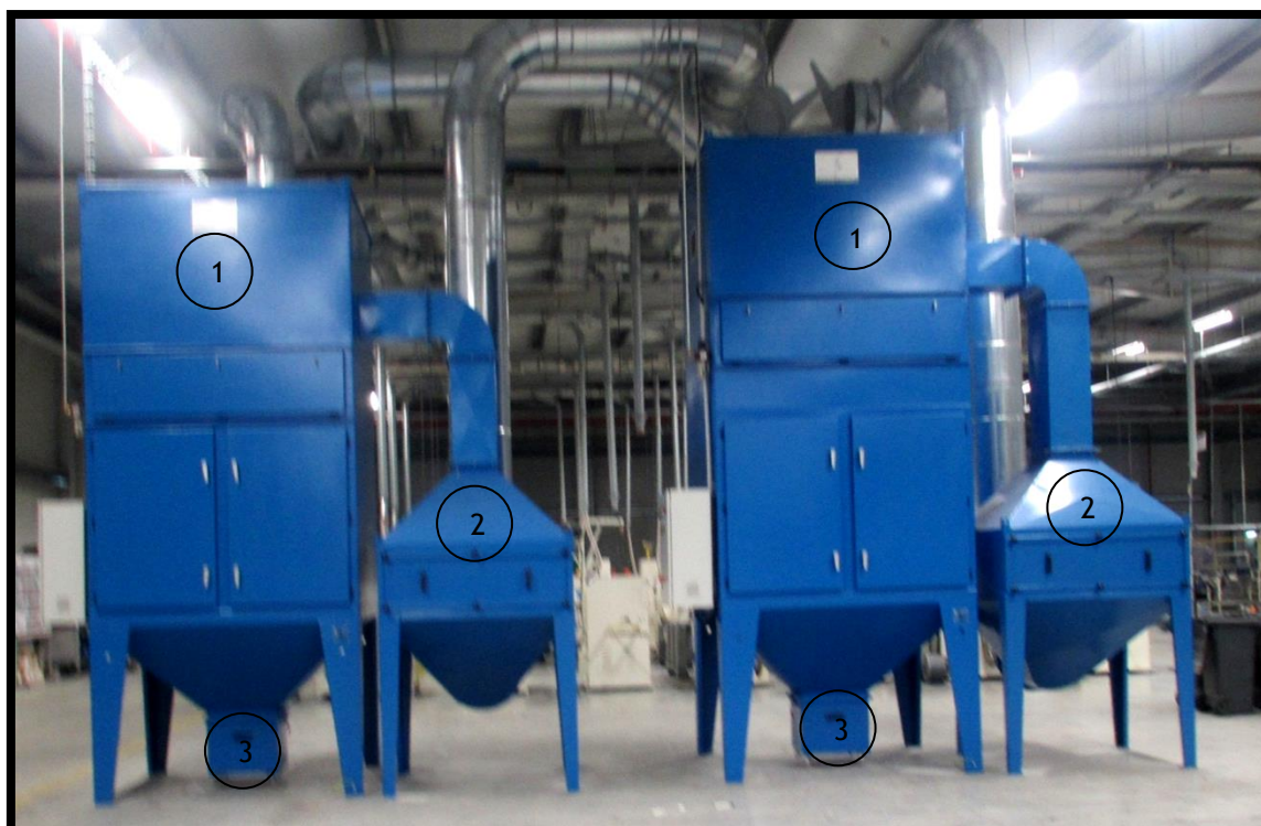
Figura 3.6 - Instalação de aspiração: 1 - Sistema de filtragem de cartuchos; 2 - Sistema de filtragem “HEPA”; 3 - Reservatório de recolha do pó.
