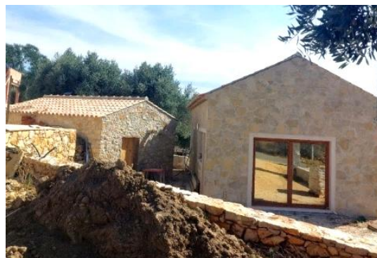
Fig. 119 _ Habitação reabilitada com os princípios vernaculares, na aldeia de Poios (2025)
