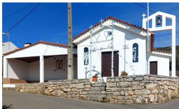
Fig. 101_ Capela de São João, amplificada pelo povo em 1988, na aldeia de Poios (2025)
