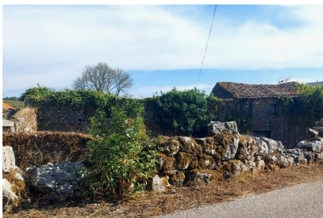
Fig. 11_ Zona habitacional em ruína, na aldeia de Ereiras (2025)
