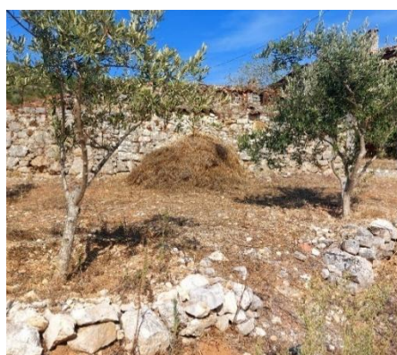
Fig. 106_ Presença de muros de pedra solta, na aldeia de Poios (2025)
