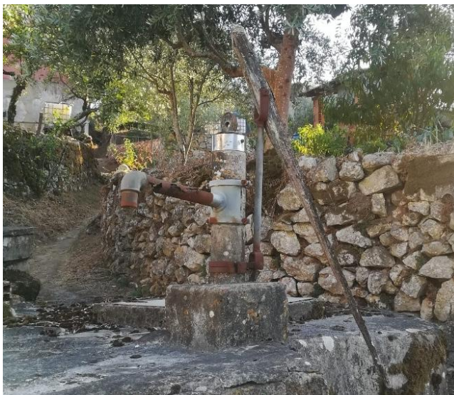
Fig. 6_ Antigo sistema de elevação de água de um poço coletivo na aldeia de Jagardo, freguesia de Redinha (2025)
