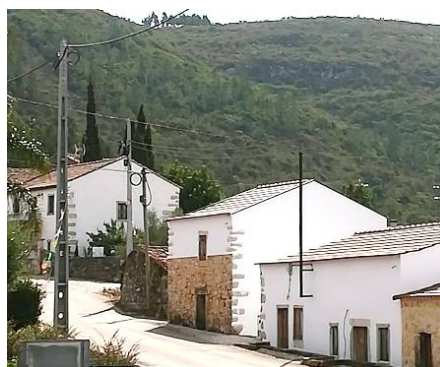
Fig. 108_ Reabilitação de habitações que preservam a imagem vernacular de Poios (2025)
