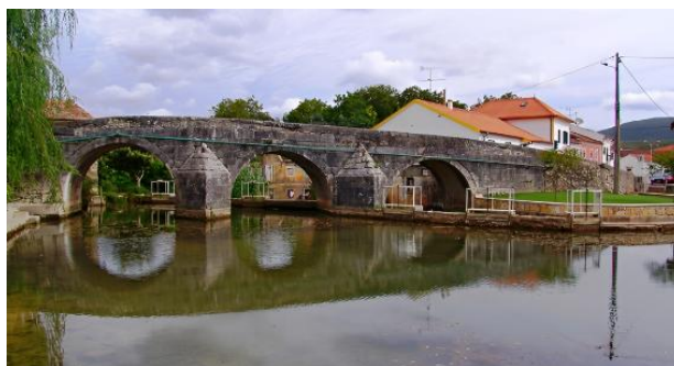
Fig. 74_ Ponte romana de Redinha sobre o rio de Anços, na perspetiva frontal da rua da Lâmpada, pertencente ao município de Pombal, fotografia de Jorge Bastos (s.d.)
