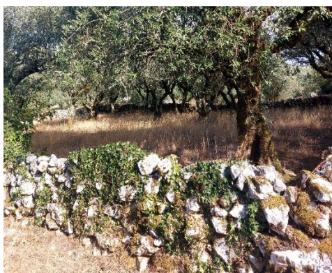
Fig. 80 _ Muro de pedra solta, na aldeia de Ereiras, (2025)
