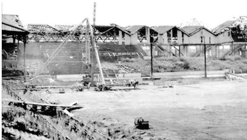
Figura 15 - Estádio de Old Trafford depois de ser destruído (Álvarez, 2017)
