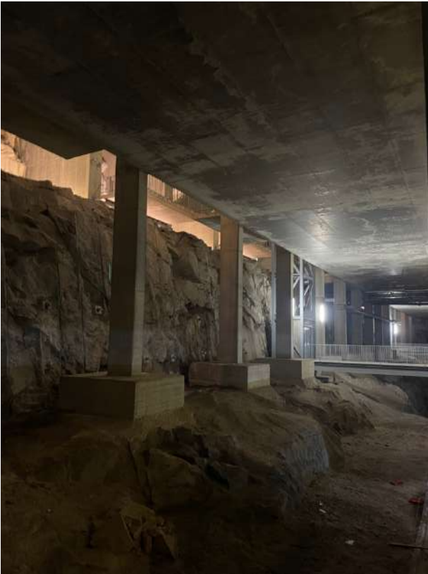
Estrutura da Bancada
