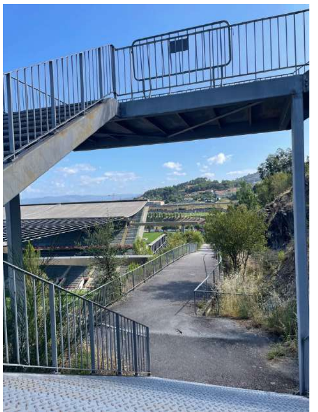
Percurso exterior do estádio
