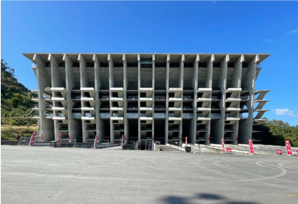
Figura 68- Bancada nascente (Foto do autor)
