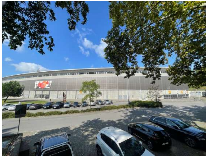
Figura 61 - Fachada Nascente (Foto do autor)
