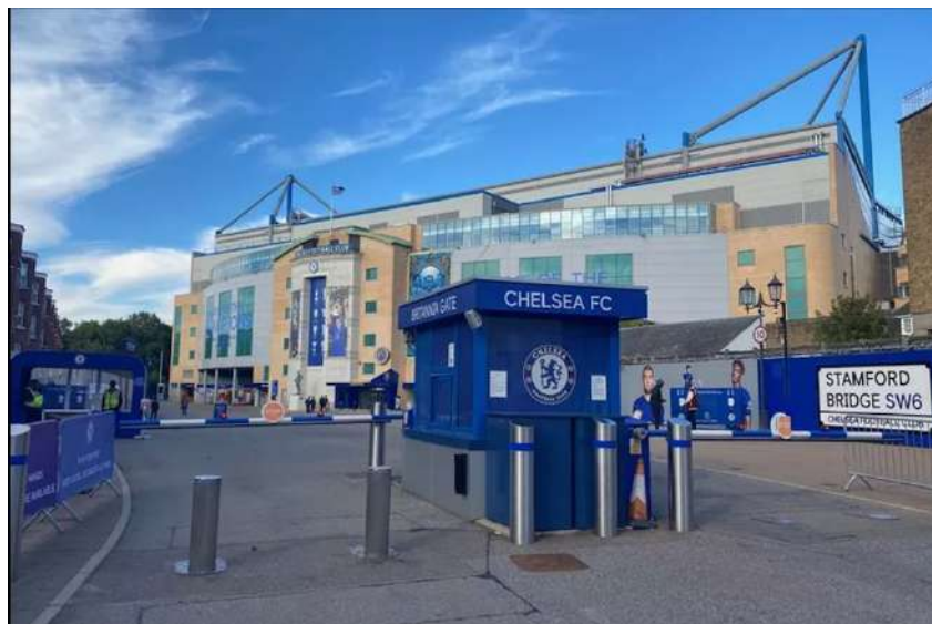
Figura 24- Fachada principal do Estádio (Byrne, 2022)
