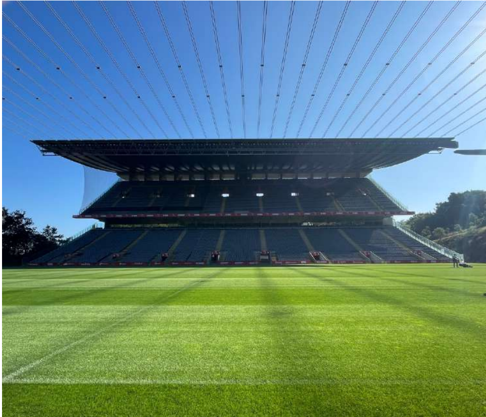
Visão ao nível do Relvado sobre a bancada Norte
