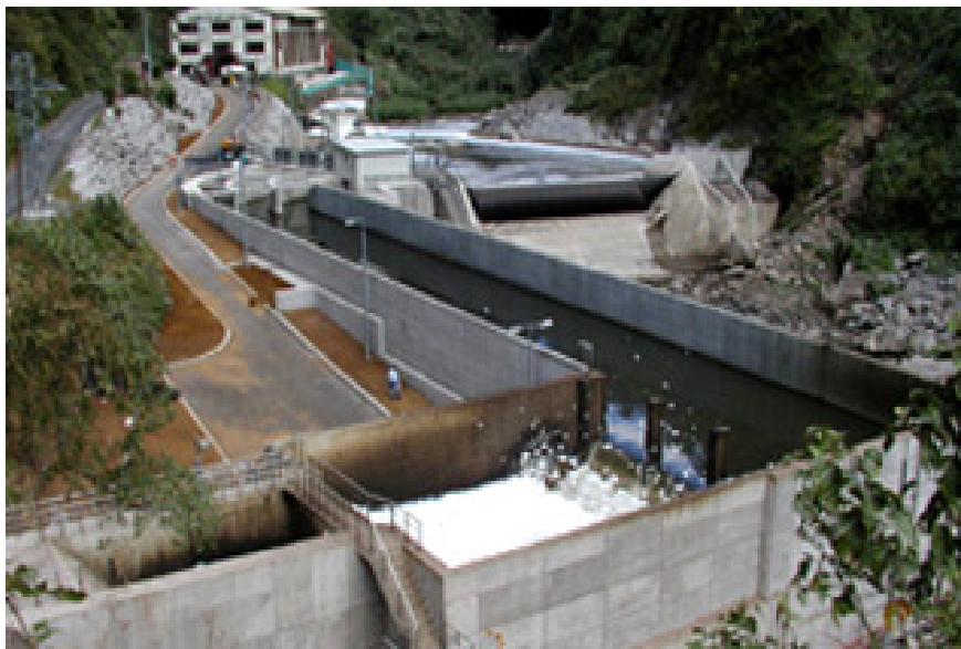
Figura 3.5 - CMH a fio de água (extraído de [24])
