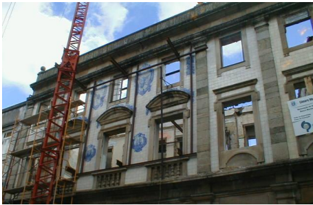
Vista exterior do edifício, escoramento do pano de parede de granito
