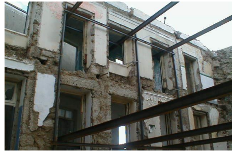
Vista interior do edifício, escoramento do pano de parede de granito
