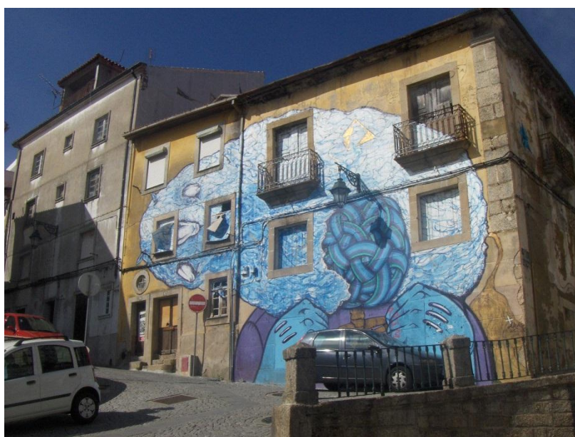
Figura nº 47 - Pinturas em edifícios degradados na freguesia de Santa Maria.
