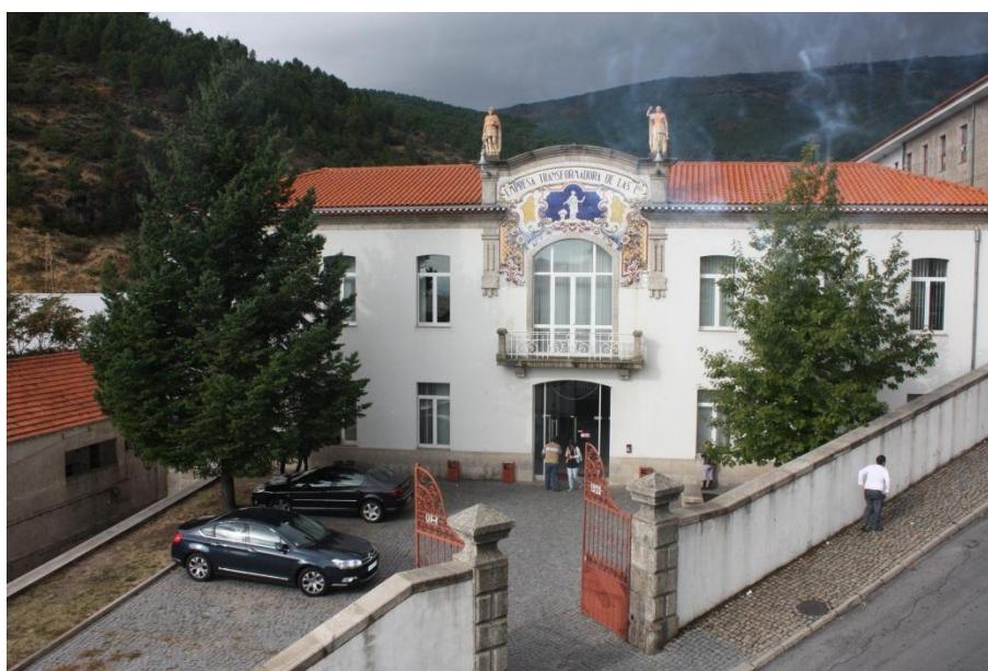
Figura nº 35 - Edifício II da Faculdade de Engenharia.
