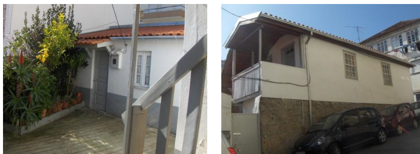
Figura nº 32 - Casa na Rua do Rodrigo nº 17.
