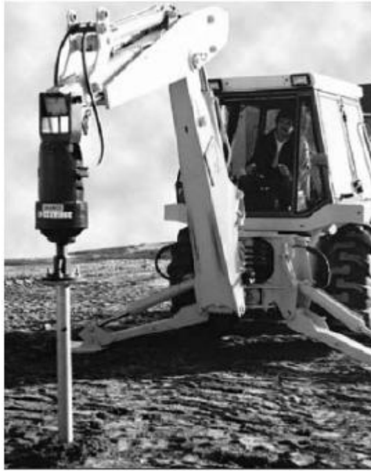
Figura 1.1 - Processo de cravação de estacas parafuso (srew piles) [4]
