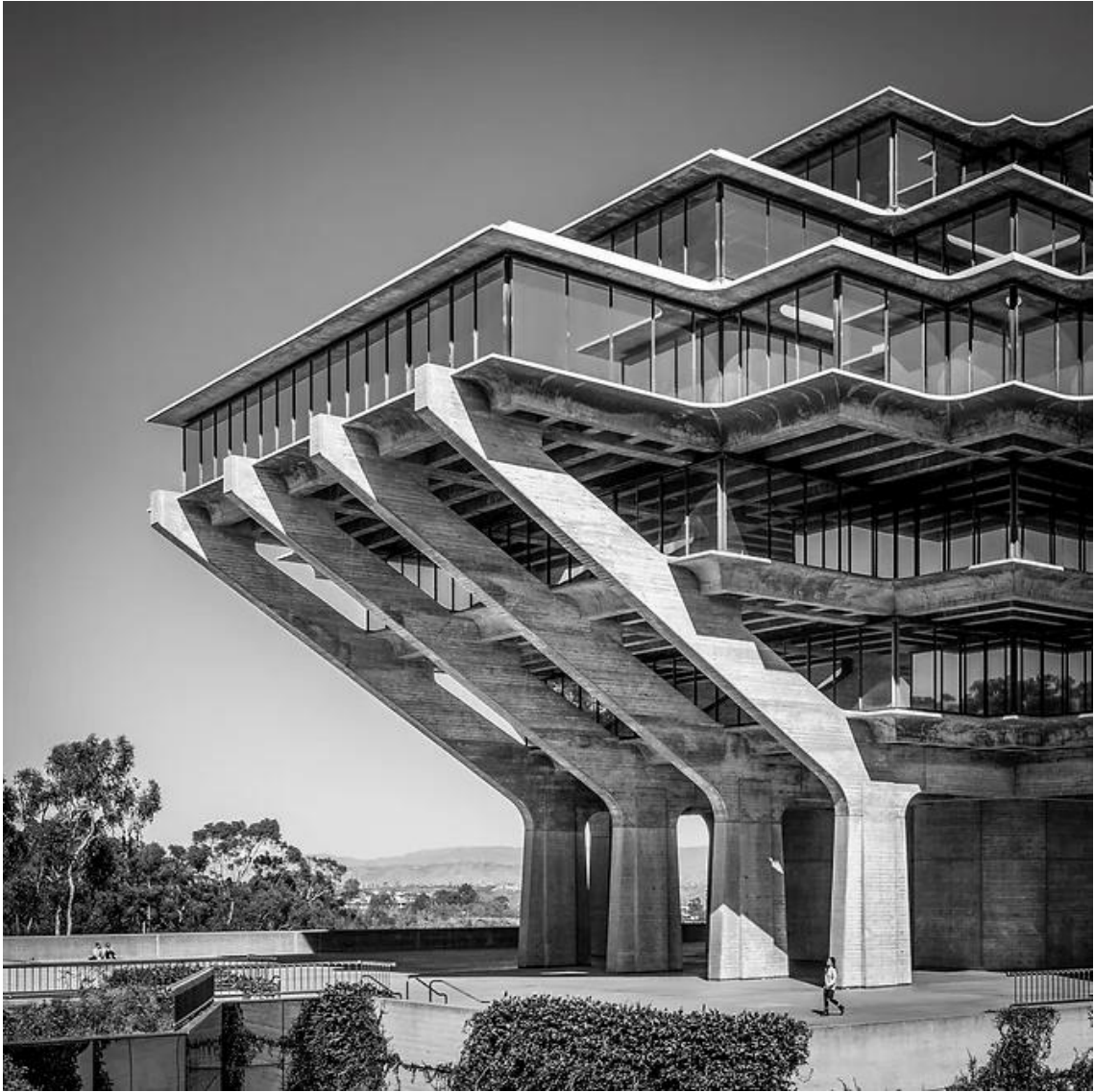
Figura 61 - Pilares e vigas oblíquas que sustentam o volume, Biblioteca Geisel.
