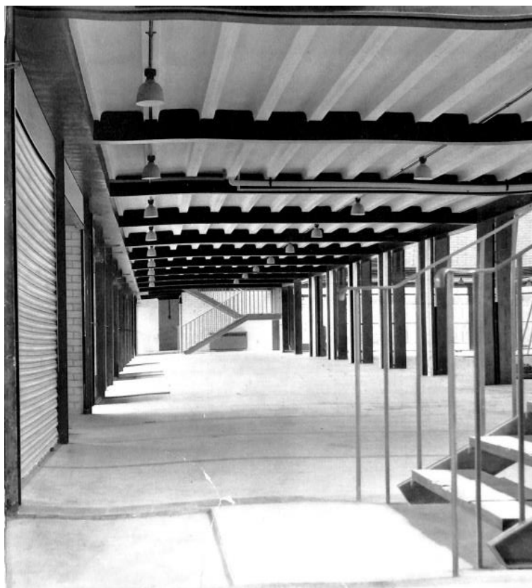
Figura 29 - Zona de entrada e acessos verticais, Escola Secundária de Hunstanton.
