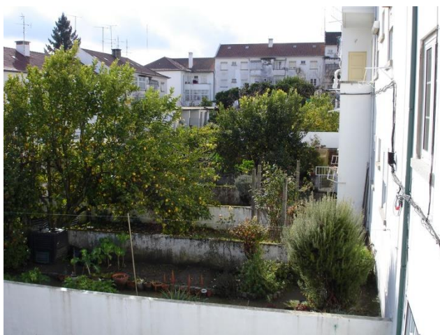
Figura 125 - Interior do bloco fechado
