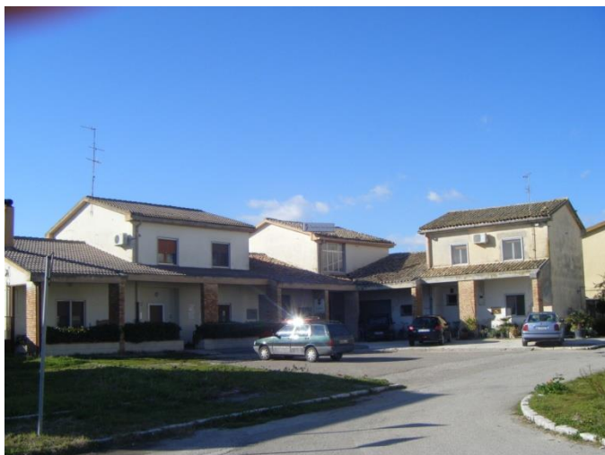
Figura 131 - Centro Serviços de La Martella
