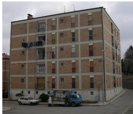
Figura 96 - edifício a bloco
