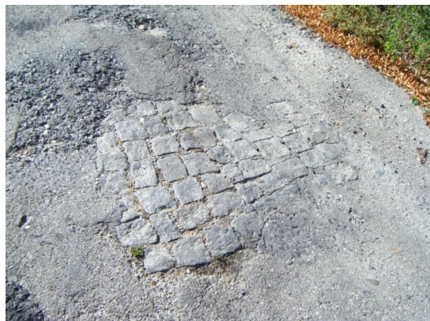
Figura 34 - Antiga pavimentação actualmente coberta de alcatrão.
