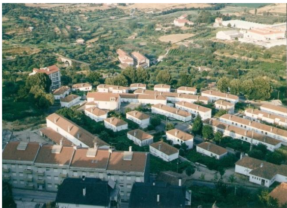
Figura 111 - Vista do bairro, Fonte João Marques Júnior
