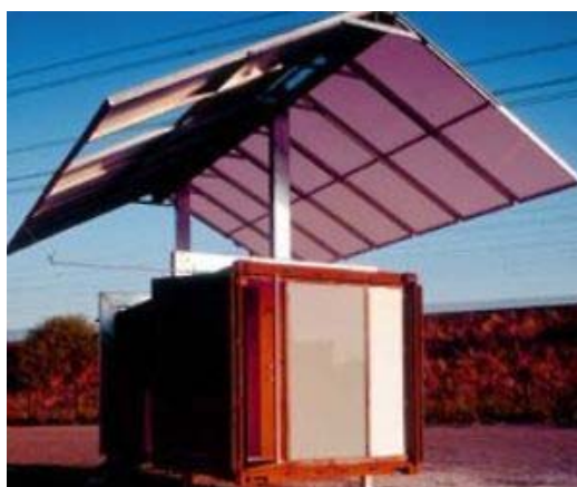
Figura 52 – Contentor marítimo adaptado para apoio em casos de cataclismos [F50]
