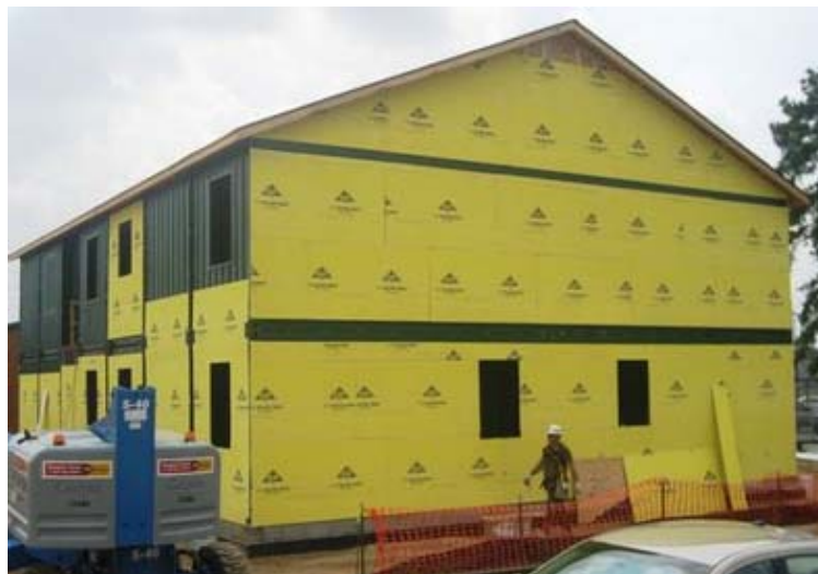
Figura 57 – Colocação de isolamento térmico pelo exterior [F55]
