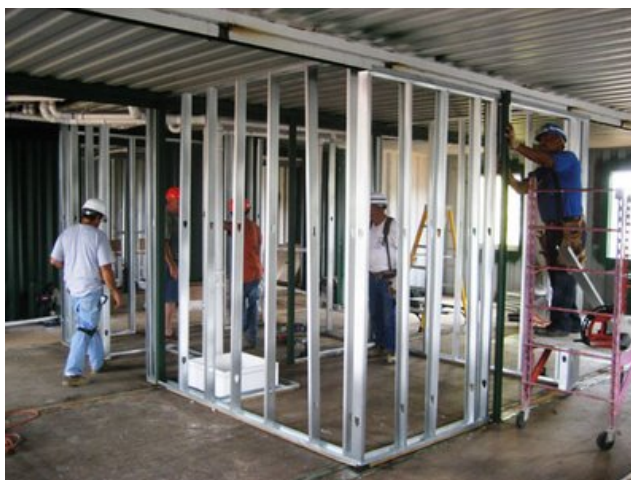
Figura 56 – Montagem de paredes interiores em gesso cartonado [F54]
