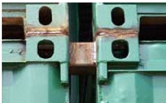
Figura 53 – União de contentores marítimos com recurso a soldadura [F51]
