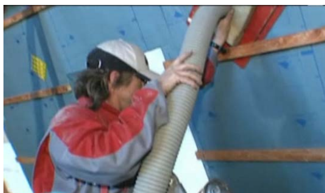
Figura 60 – Bombeamento do isolamento por mangueira [F58]
