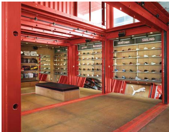
Figura 55 – Juntas entre contentores [F53]
