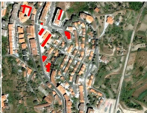
Figura 130 - Serviços e instalações colectivas bairro Rodrigo
