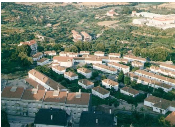
Figura 111 - Vista do bairro, Fonte João Marques Júnior
