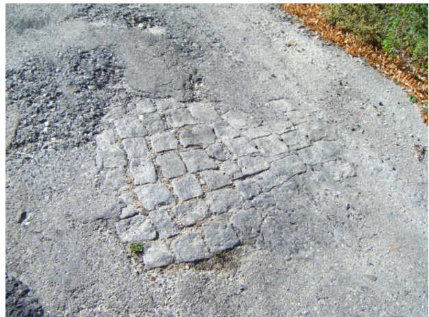
Figura 34 - Antiga pavimentação actualmente coberta de alcatrão.
