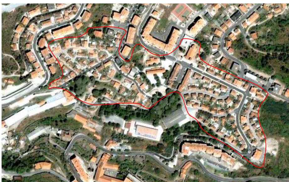
Figura 144 - Foto aérea do bairro dos Penedos Altos
