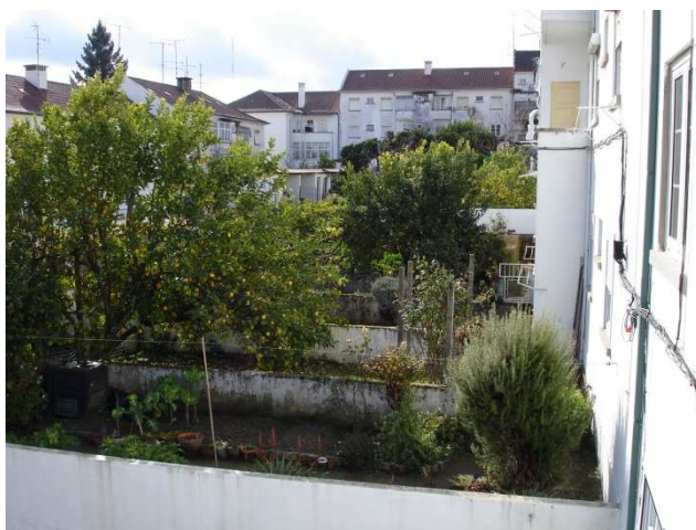
Figura 125 - Interior do bloco fechado
