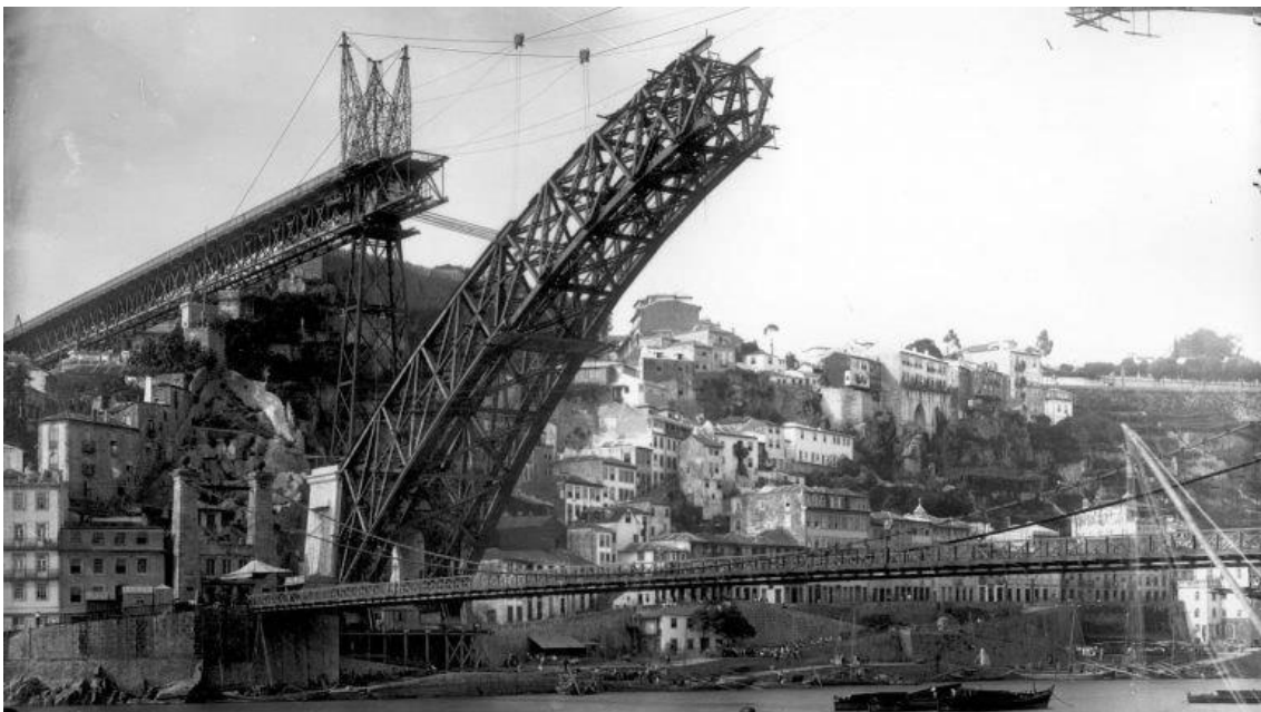
Figura 1- Ponte D.Luís I em construção
