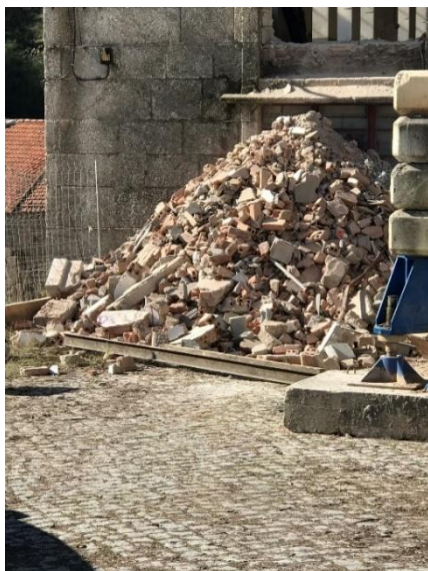
Figura 65- Resíduos de demolição produzidos em obra;
