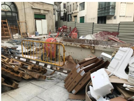
Figura 29- Resíduos produzidos em obra. Organização do RCD de acordo a sua tipologia
