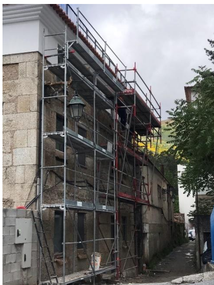
Figura 55- Andaime presente em obra
