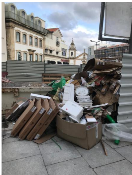
Figura 27- Resíduos produzidos em obra
