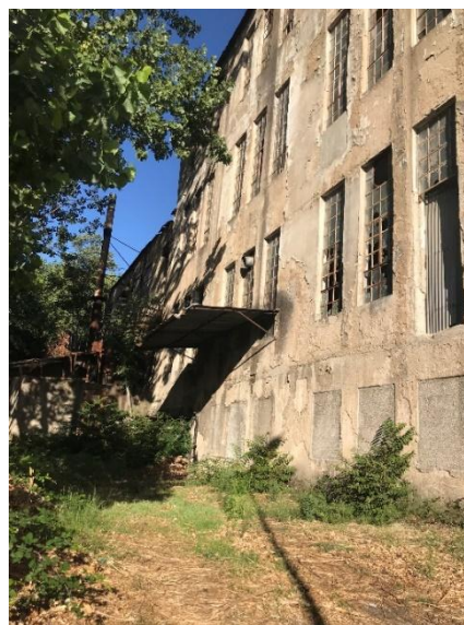
Figura 46- Estado do edifício antes da requalificação
