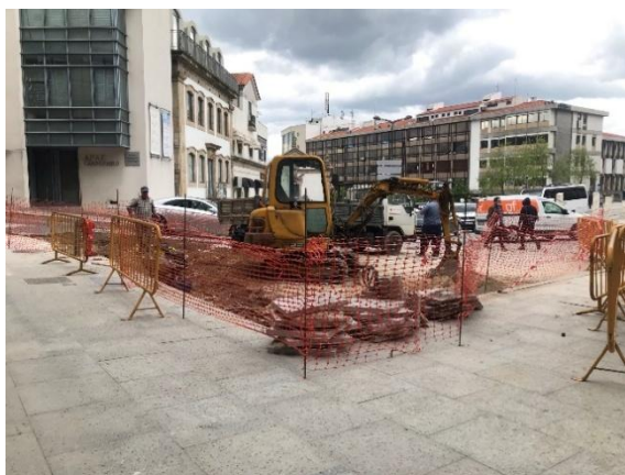
Figura 36- Execução de trabalhos finais
