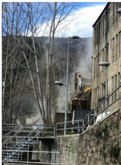
Figura 66- Produção de poeiras resultantes das demolições;
