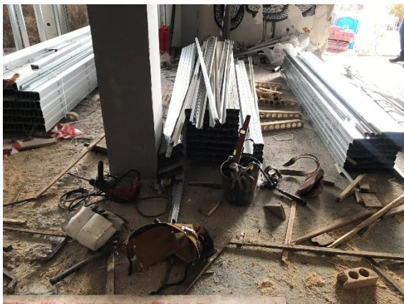
Figura 57- Materiais armazenados no interior do edifício
