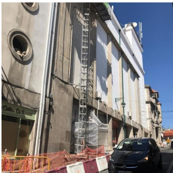
Figura 31-Sinalização de segurança da obra
