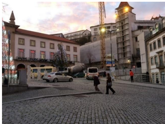
Figura 26- Fornecimento de betão à obra;
