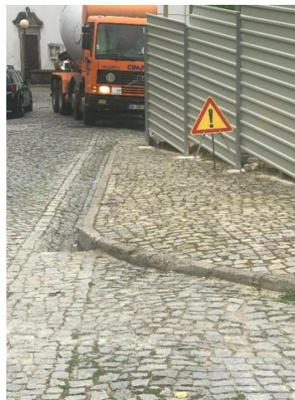
Figura 60- Fornecimento de betão a obra
