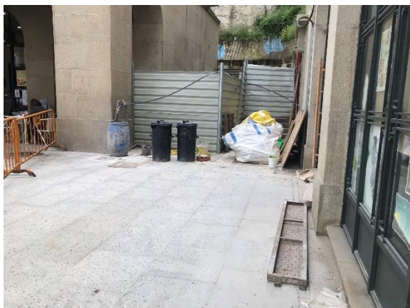
Figura 37- Vedação de chapa lacada do estaleiro
