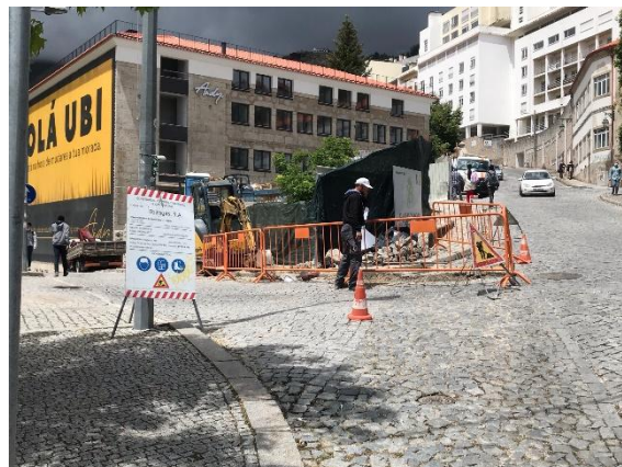
Figura 74- Execução de trabalho finais no exterior do edifício.
