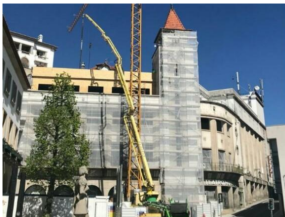
Figura 76- Andaime e aleados de proteção em obra de reabilitação urbana
