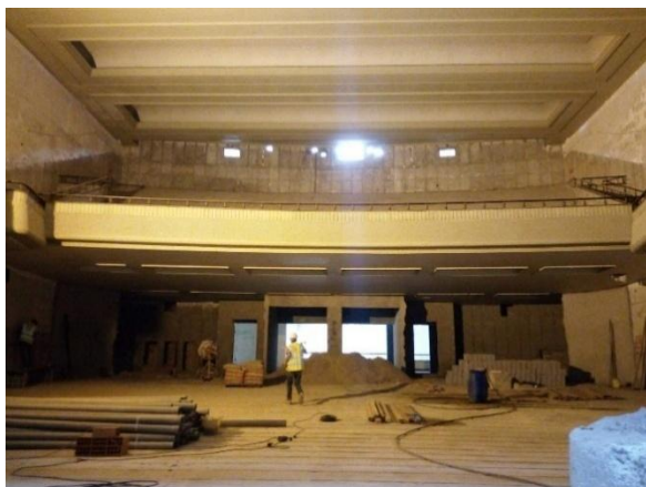
Figura 21- Imagem de execução de trabalhos no interior do edifício
