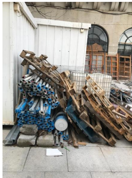
Figura 28- Materiais arrumados no estaleiro
