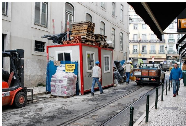
Figura 77- Implicações na circulação devido a presença do estaleiro de obra [45]
