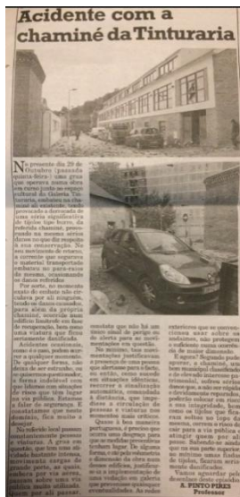
Figura 61- Danos causados pela grua. Informação partilhada no jornal local, sobre o acidente da grua
