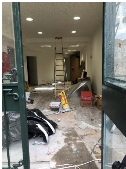
Figura 40- Execução de trabalhos finais da obra
