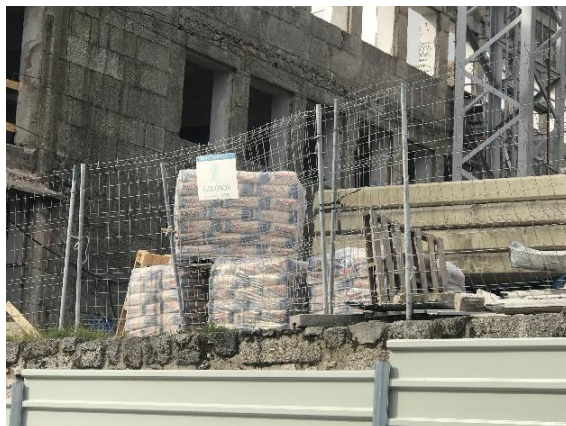
Figura 52- Materiais arrumados em obra
