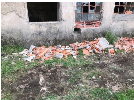
Figura 49- Execução de demolição
