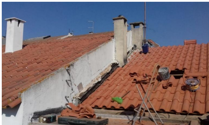
Figura 6 - Reparação do telhado [25]
