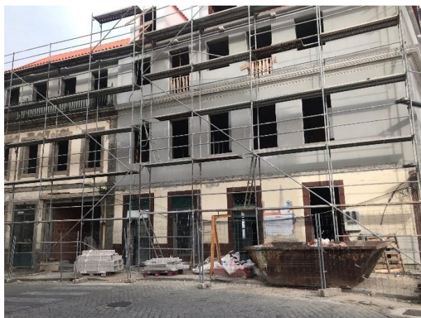
Figura 7- Reabilitação do edifício
