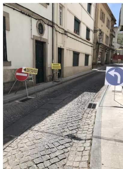
Figura 82- Sinalização de segurança
