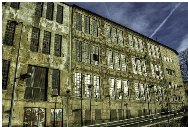
Figura 41- Estado do caso de estudo antes da reabilitação
