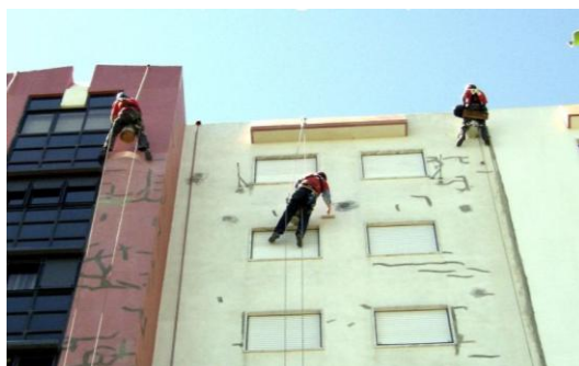
Figura 5- Reparação de fissuras[24]
