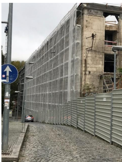
Figura 69- Rede de proteção colocada nos andaimes de modo prevenir queda de materiais
