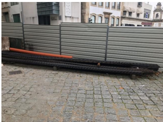
Figura 23- Fornecimento de armaduras a obra
