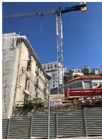
Figura 56- Grua de grande porte da obra
