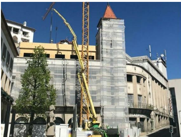
Figura 25- Fornecimento de betão à obra;
