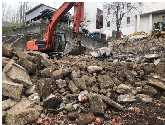
Figura 48- Execução de demolições
