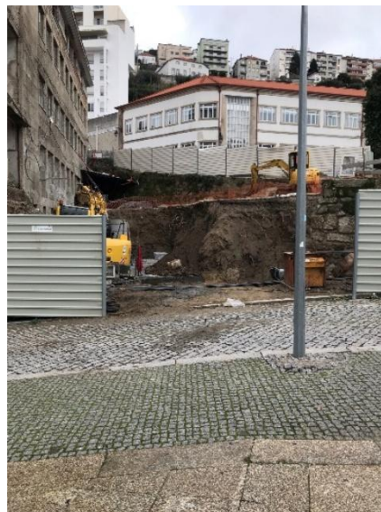
Figura 58- Execução de escavação para construção de escadas
