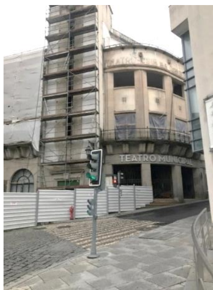
Figura 32- Vedação metálica em volta da obra
