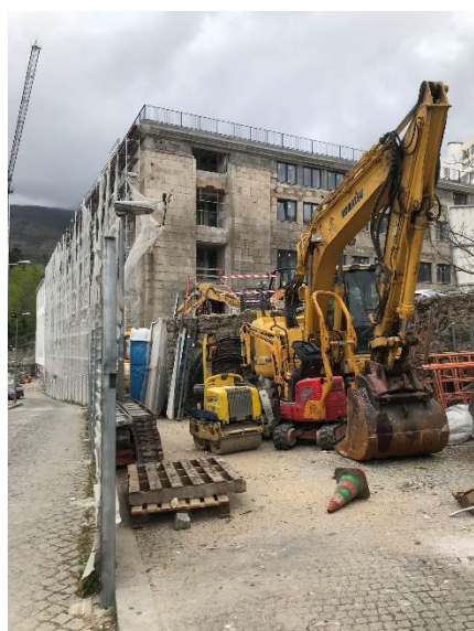
Figura 53- Máquinas armazenadas no exterior da obra
