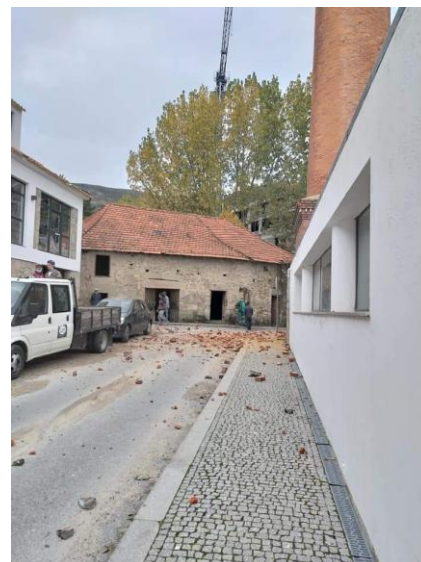
Figura 62- Danos causados pela grua. Informação partilhada no jornal local, sobre o acidente da grua
