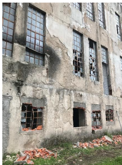
Figura 50- Execução de demolição
