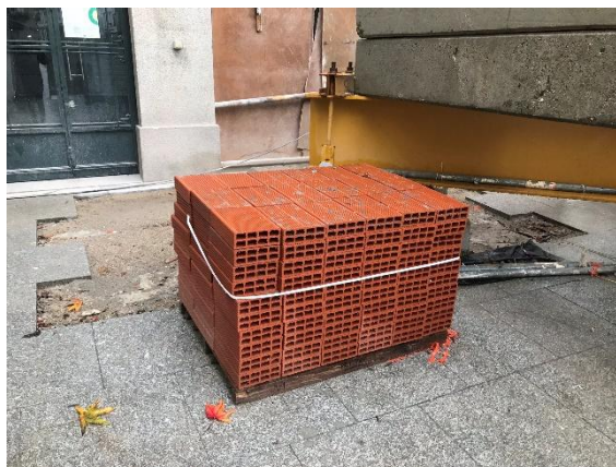
Figura 24- Fornecimento de material da obra;
