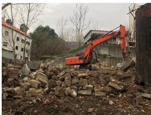
Figura 8- Demolição de edifício.
