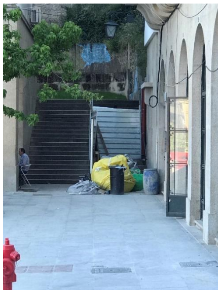
Figura 39- Execução de trabalhos finais da obra
