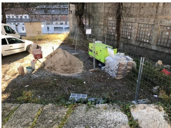
Figura 47- Fornecimento de materiais e equipamentos para execução de trabalhos preparatórios
