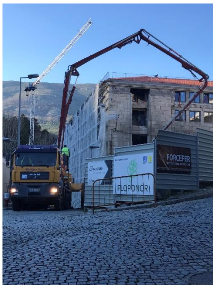
Figura 59- Fornecimento de betão a obra
