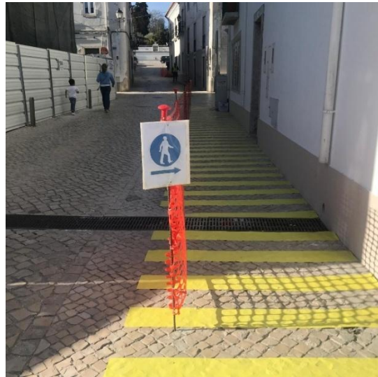
Figura 80- Sinalização de segurança e desvio de acesso
