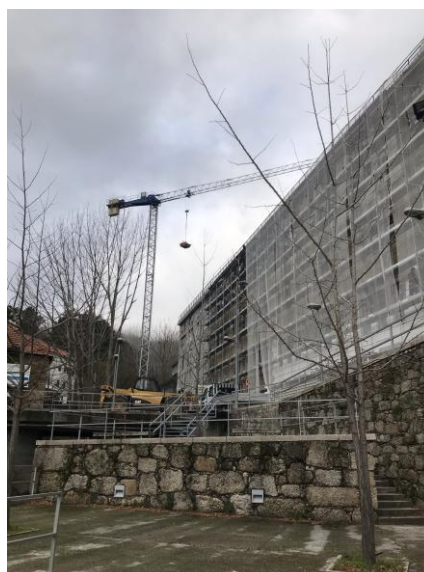
Figura 54- Grua de grande porte da obra
