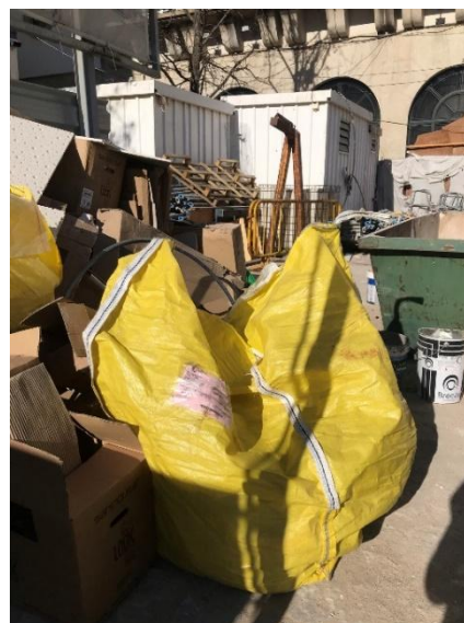
Figura 30- Resíduos produzidos em obra
