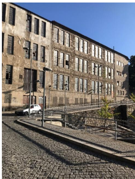
Figura 45- Estado do edifício antes da requalificação
