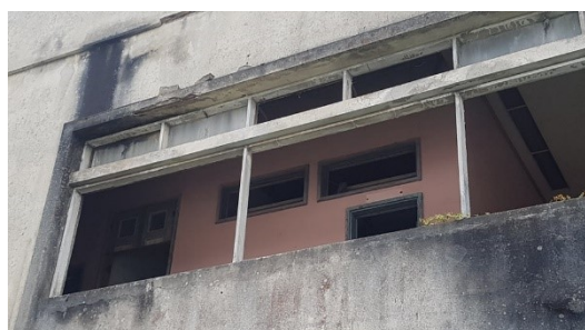
Fig.69 - Pormenor do 2º piso visto do lado Norte.
