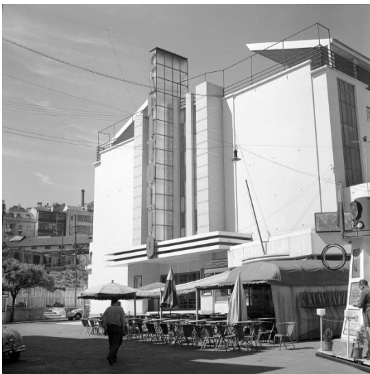
Fig.35 - Vista Principal com a entrada para o Cineteatro Capitólio, com a cobertura em construção sobre o terraço existente. Fonte: “Cine-Teatro Capitólio”, Restos de Coleção; 2011.
