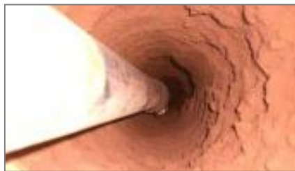
Figura 4.20 - Imagem do fuste e do solo envolvente, imediatamente após a instalação da estaca helicoidal.
