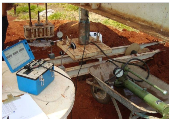
Figura 3.15 - Sistema de aquisição de dados, extensômetros, macaco hidráulico, célula de carga e bomba hidráulica usados nos ensaios de carga em estacas do campo experimental.
