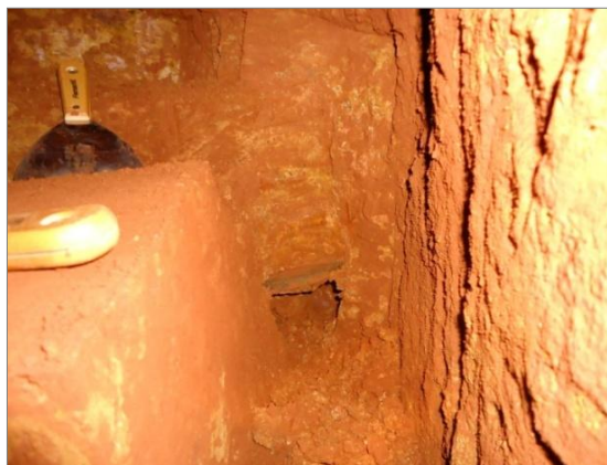
Figura 3.10 - Recolha da amostra indeformada à profundidade de 9 m.
