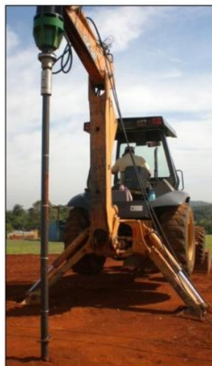
Figura 3.13 - Instalação de uma estaca helicoidal no campo experimental de estudos.
