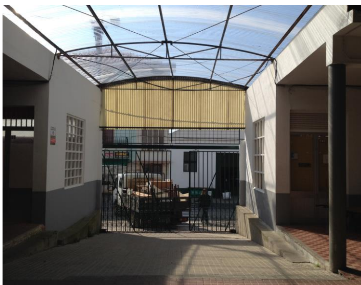
Figura 51 - Levantamento fotográfico do existente: espaços comerciais.
