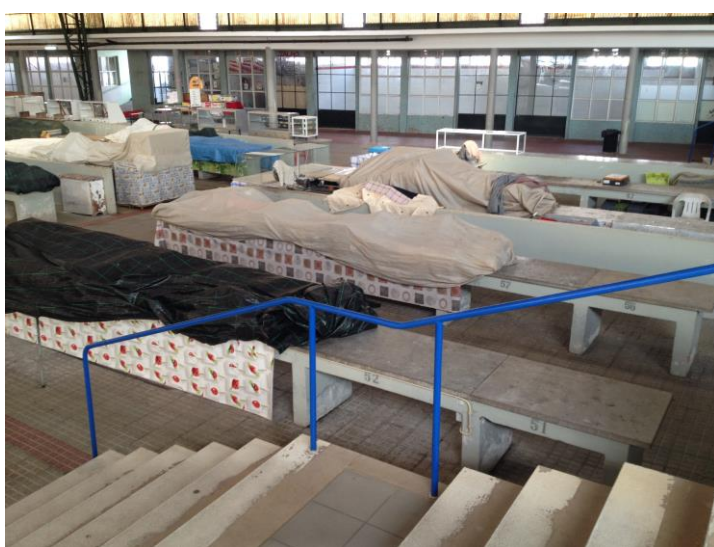
Figura 50 - Levantamento fotográfico do existente: espaços comerciais.
