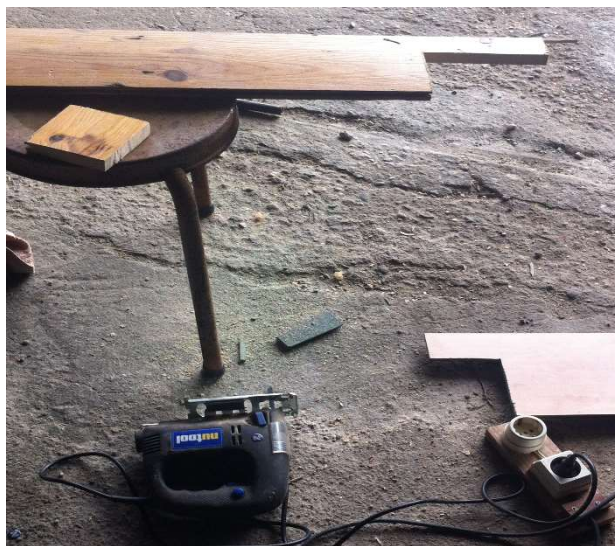
Figura 30: Corte do soalho e do flutuante com auxílio de uma serra elétrica.
