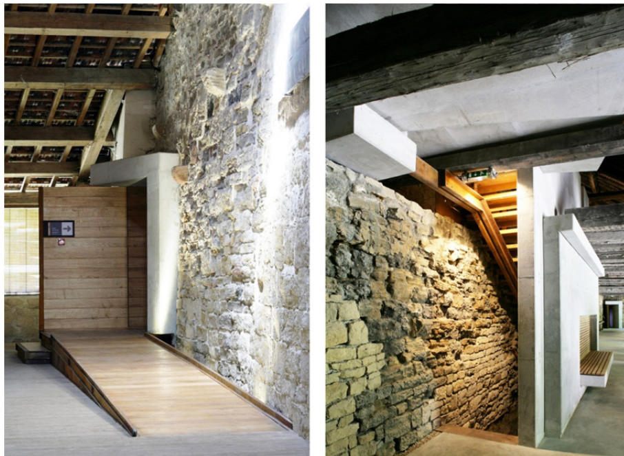
Fig. 23 - Pormenores da adição dos elementos modernistas no edificado existente da salina. In www.architectes.org/portfolios/agence-malcott-roussey/ .
