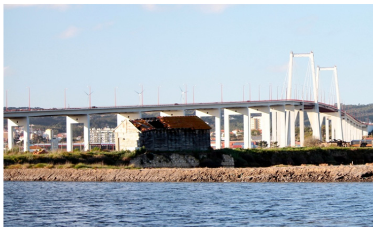
Fig. 60 - Armazém exemplificativo da condição ruínosa em que grande parte destas unidades se encontra. Imagens do autor.
