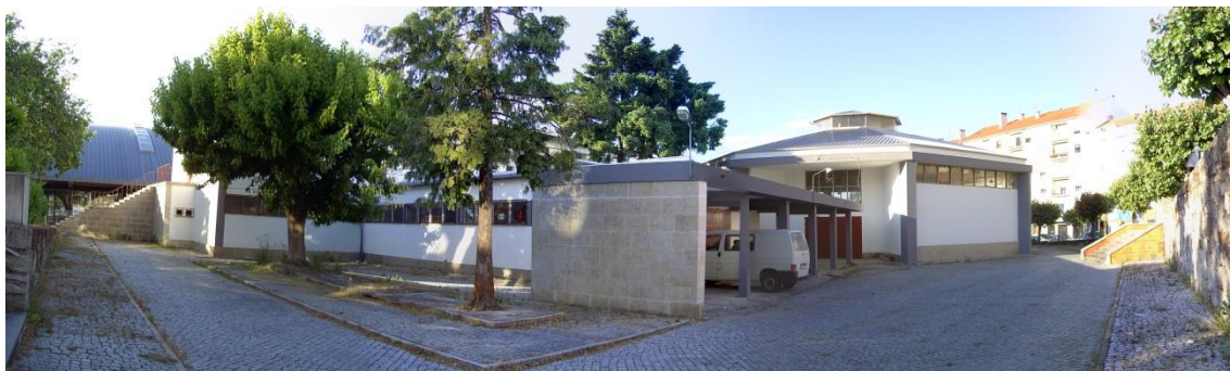
Figura 15- Panorâmica Sul do edifício da antiga praça municipal.
