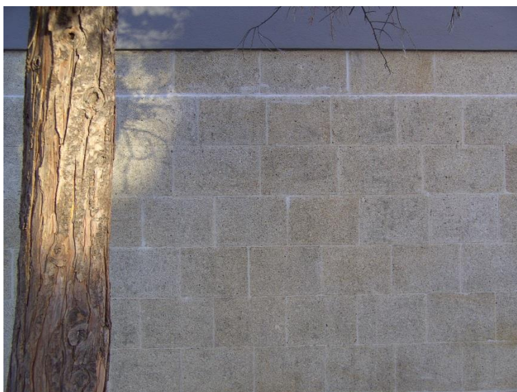
Figura 16- Exemplo no local da conjugação dos 3 materiais (madeira, pedra e betão)
