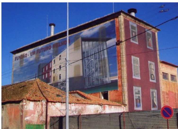
Figura 6- Moagem de Centeio do Fundão (edifício devoluto).
