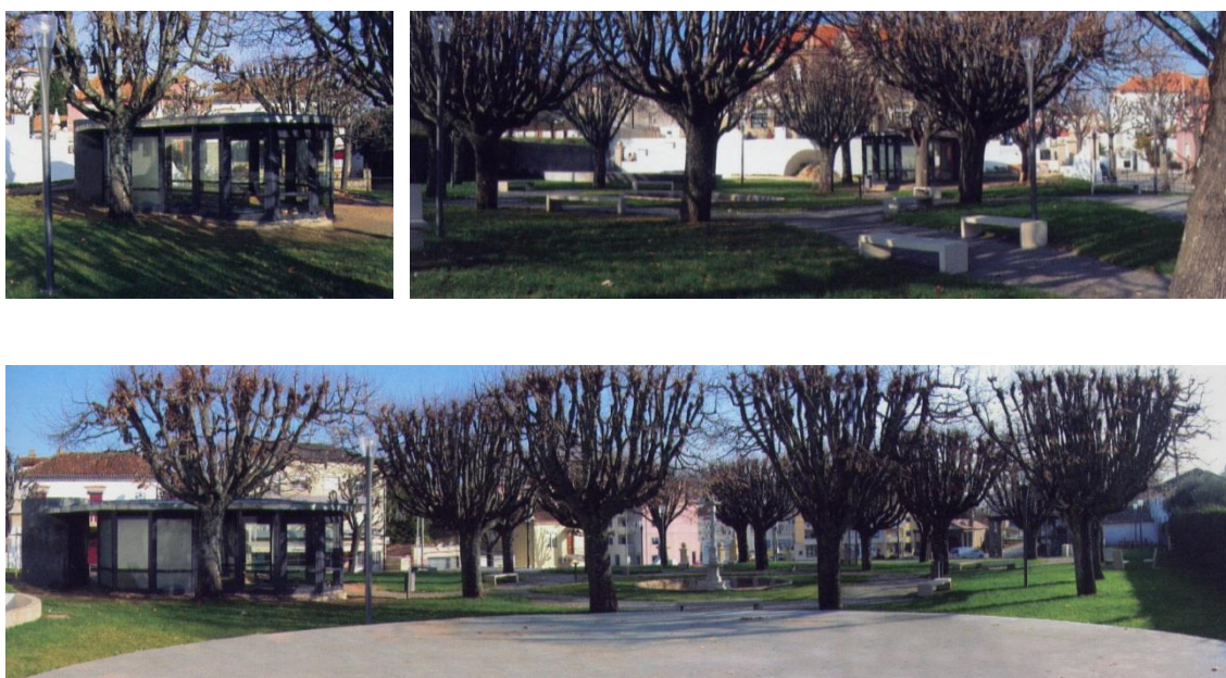
Figura 8- Casa de Chá - Parque das Tílias (edifício original).
