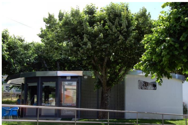
Figura 11- Casa de Chá, fachada Nordeste (depois da intervenção).
