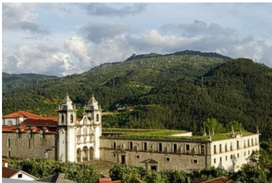
Fig. 44 - Fachada Lateral do Mosteiro St a Maria do Bouro
