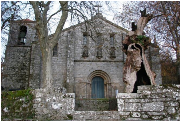
Fig. 33 - Fachada do Mosteiro de Fiães
