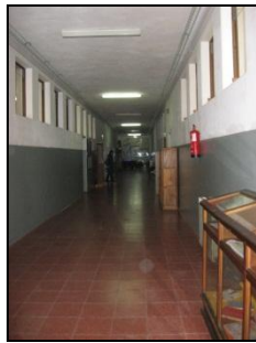
Figura 1.15 - Corredor do 4.º piso na ESAL.
