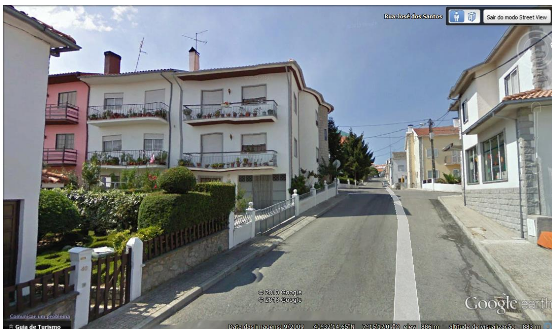
Figura 91 - Imóvel “A” e envolvente - vista nascente, a partir da Rua José dos Santos (Fonte: Google Earth)
