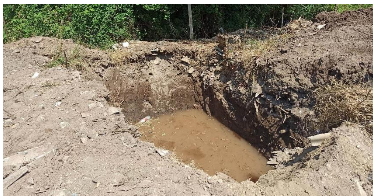
57. Primeira fase de obra – escavação e colocação do ramal de água, em 28 de dezembro de 2021. (Jornal dos Bairros Saudáveis, 2021b)
