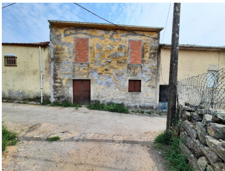
67. Imóvel devoluto a ser reabilitado para habitação (somente o primeiro piso será intervencionado e acede-se pelo interior da ilha). (Autor, 2022)
