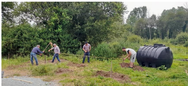
61. Moradores da comunidade da Carvalhosa e funcionários d'Os Pioneiros a trabalhar em conjunto nas obras do balneário público, em maio de 2022. (Balneário Comunitário - "Os Pioneiros", 2022)
