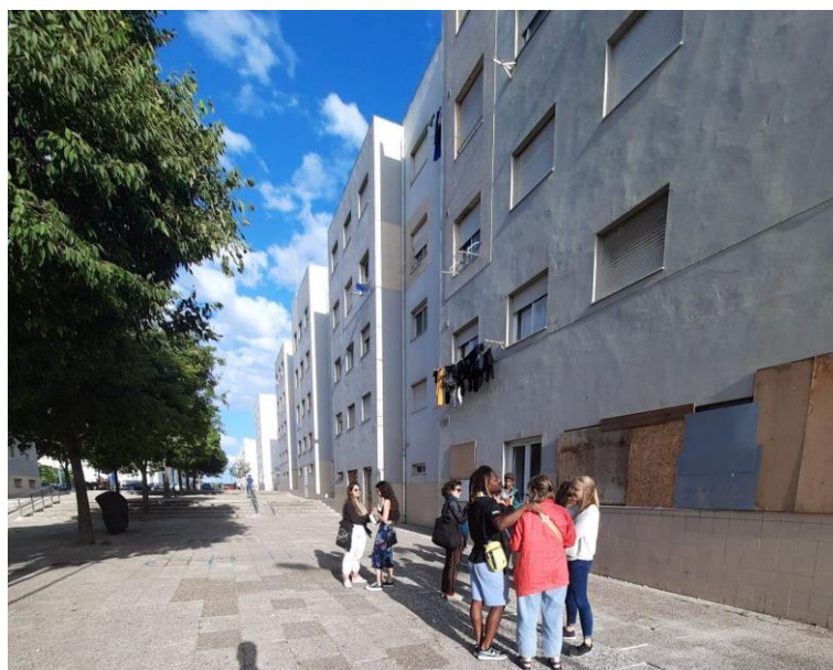
50. Espaço público e edifícios do bairro Alto dos Barronhos. (Autor, 2022)
