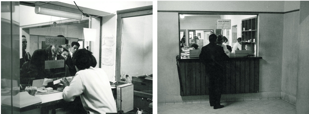
Imagem 1 e 2 – Exemplos vidros de protecção contra gotículas. Locais não identificados, mas relacionados com estruturas de atendimento a doentes potencialmente tuberculosos (dispensários).
