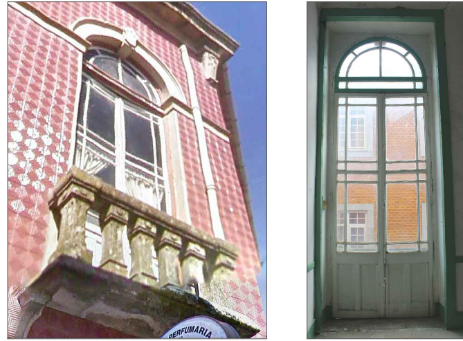
Imagem 207 e 208 - Levantamento fotográfico da Janela V5 - exterior (esquerda) e interior (direita)
