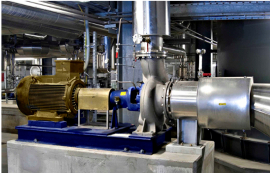
Figura 1.5: SynRM da KSB em testes numa indústria [9].
