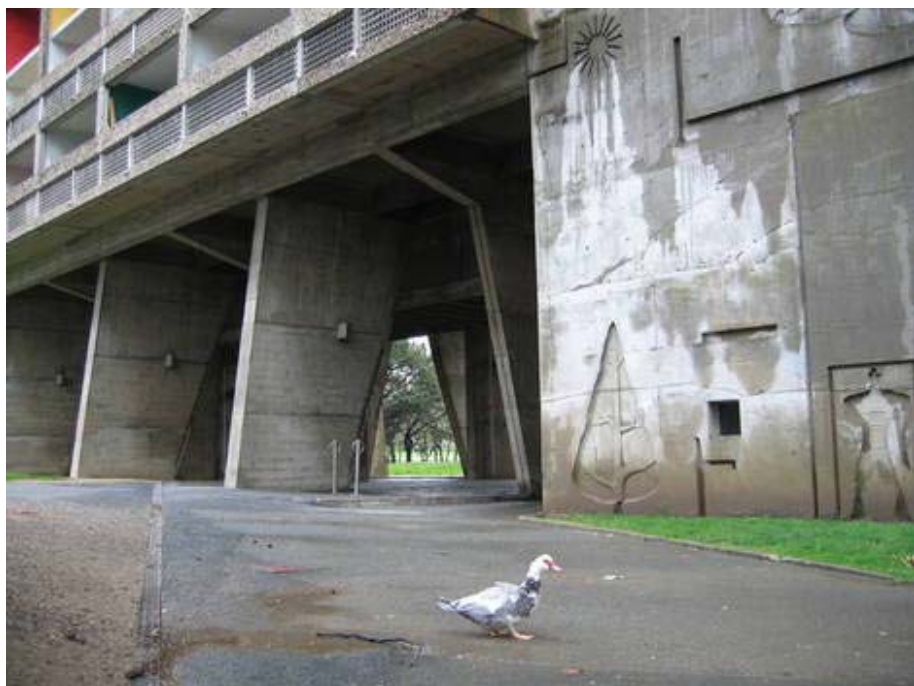
Fig.18 - Vista dos pilares em “Housing project Rezé-lès Nantes” (www.archdaily.com)
