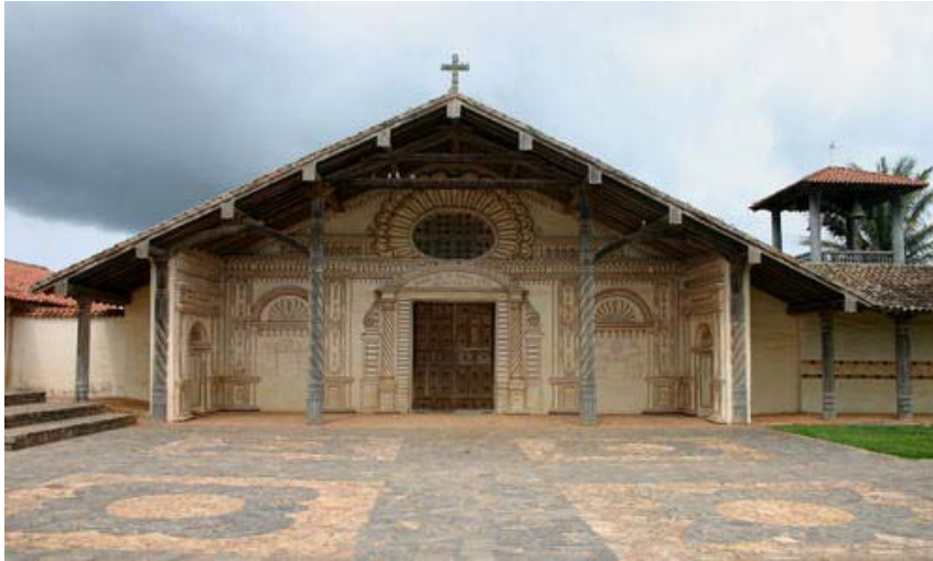
Fig.4 - Fachada da igreja de San Francisco Javier ( http://whc.unesco.org )
