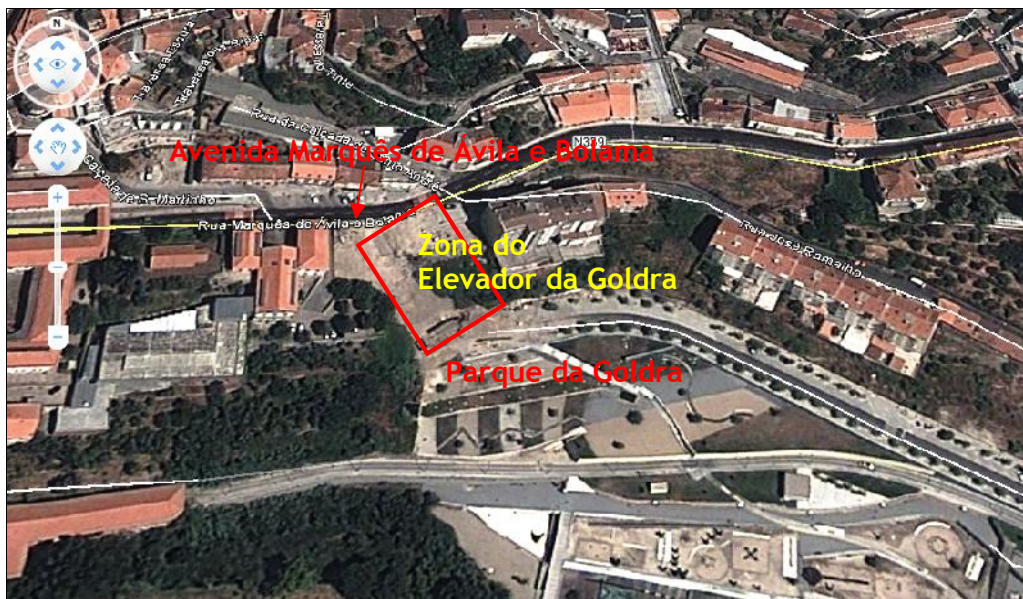
Figura 4.1 - Enquadramento urbanístico do Elevador da Goldra, na cidade da Covilhã (Google Maps, 2012).
