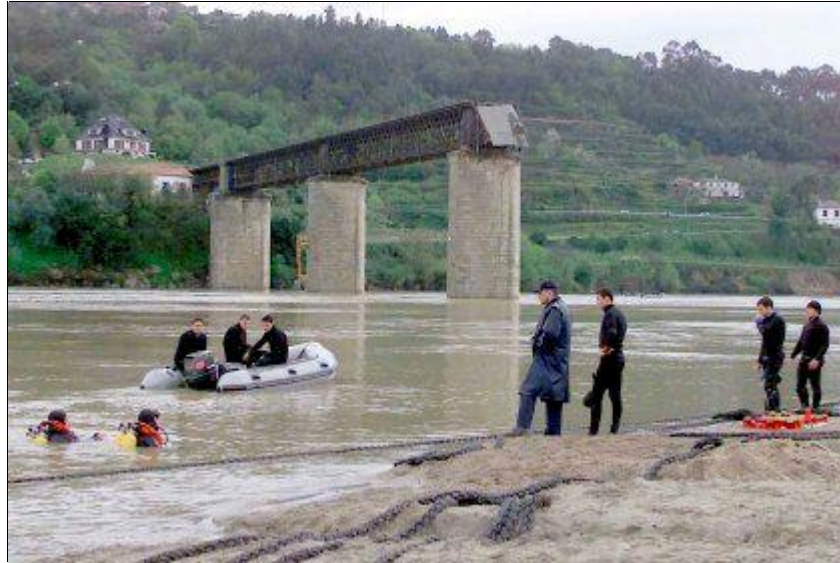
Figura 2.5 - Ponte de Entre-Os Rios. (Diário de Notícias, 2011)
