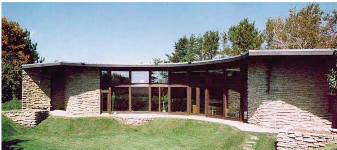
Figura 4.4 - Casa Jacob II, F.L.Wright - Fachada Sul
