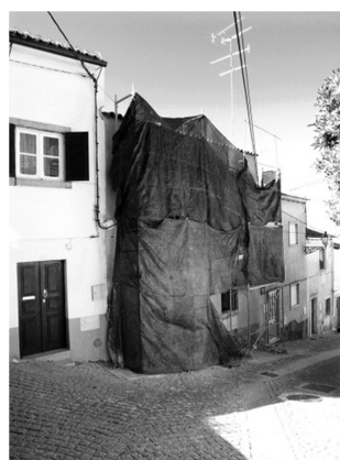
18. Obras em edifício de habitação na Rua da Sobreira
