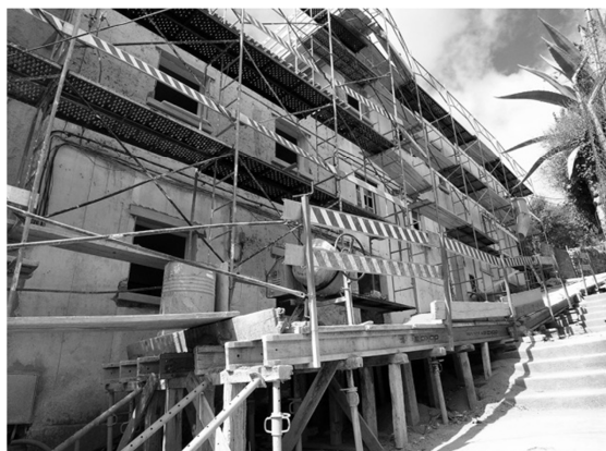
15. Obras em edifícios na Rua da Caleja Nova
