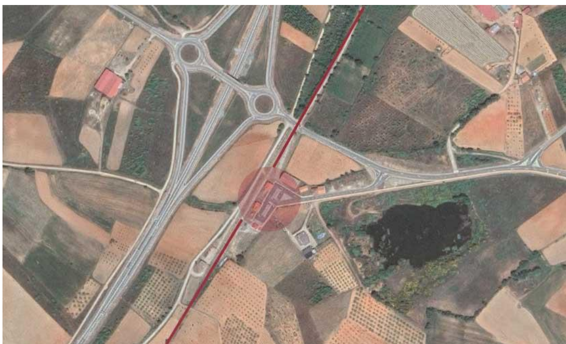
Figura 89 - Localização Estação de Sendim 268
