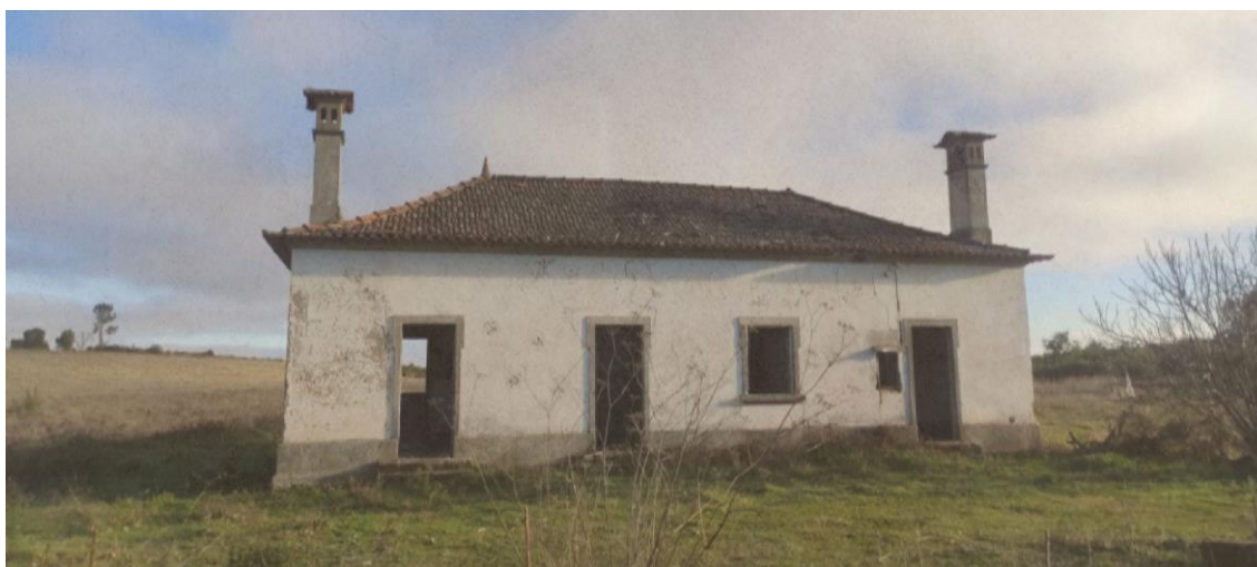
Figura 26 – Estado atual do Apeadeiro de Fonte de Aldeia 58
