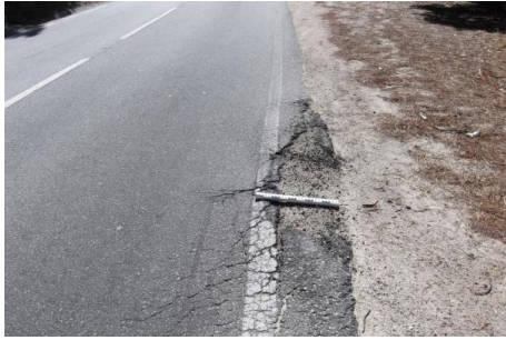
Fotografia 3 - Berma ao km 105+085
