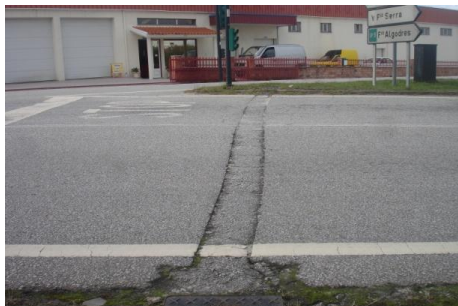
Figura 4-13: Reparações ao km 37+810
