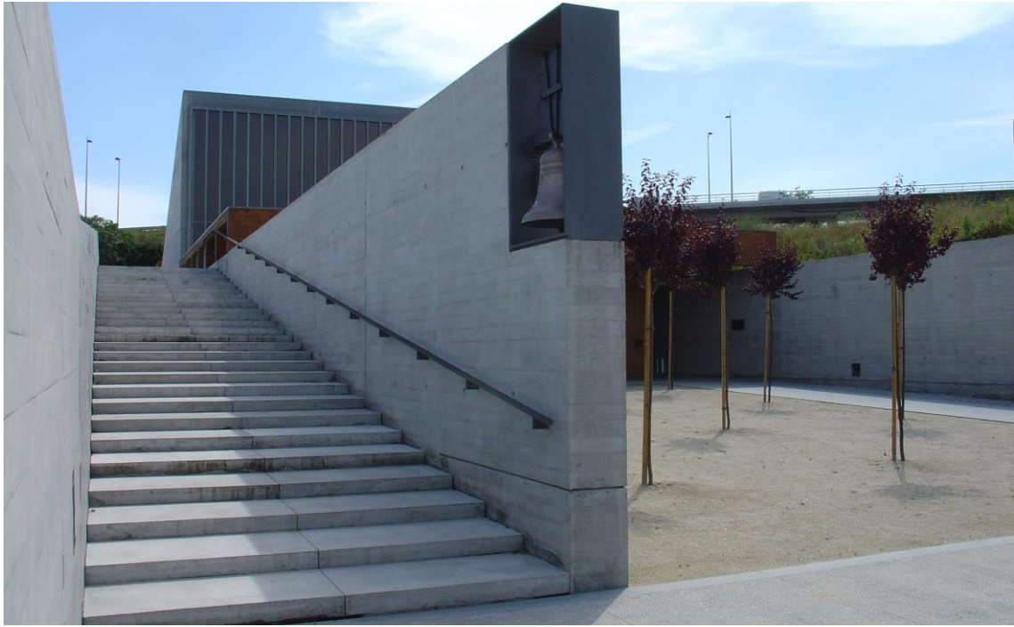
Figura 154 – Acesso Exterior, Capela de São José, Vila Nova de Gaia
