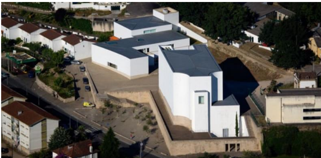
Figura 132 – Igreja de Santa Maria, Marco de Canavezes.
