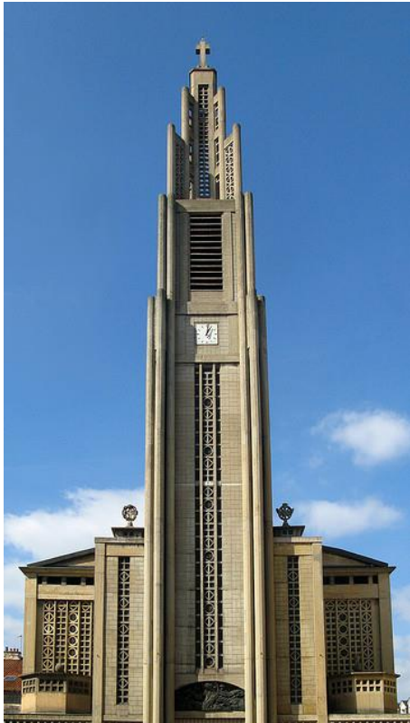
Figura 65 – Fachada, Igreja Notre Dame du Raincy
