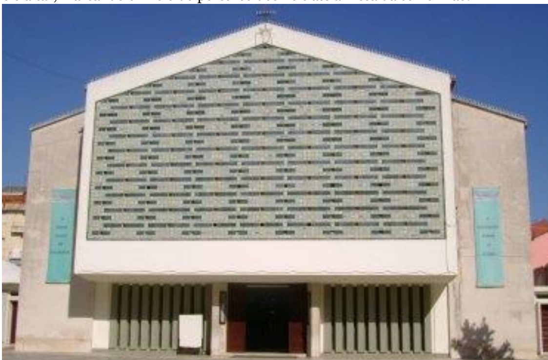
Figura 103 - Fachada da Igreja de Santo António
