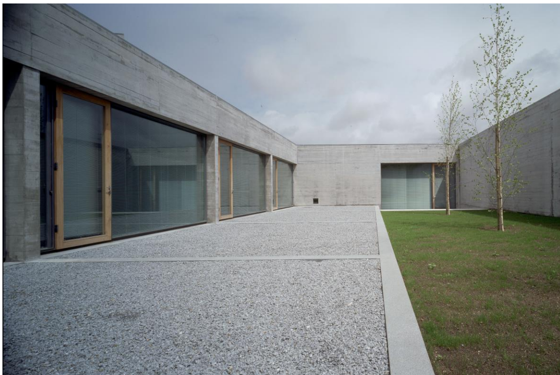
Figura 163 – Pátio da Capela de São José, Vila Nova de Gaia
