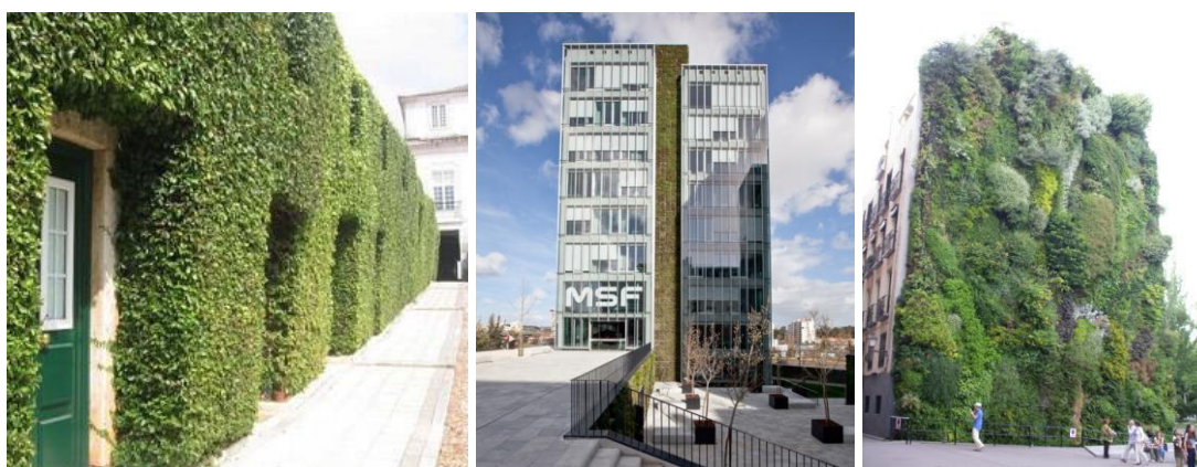
Figura 3 - Da esquerda para a direita: Quinta das Lapas, Torres Vedras [24]; Sistema Modular, Sede da MSF, Lisboa [25]; Jardim Vertical de Patrick Blanc, Caixa Forum, Madrid (Junho,2011).
