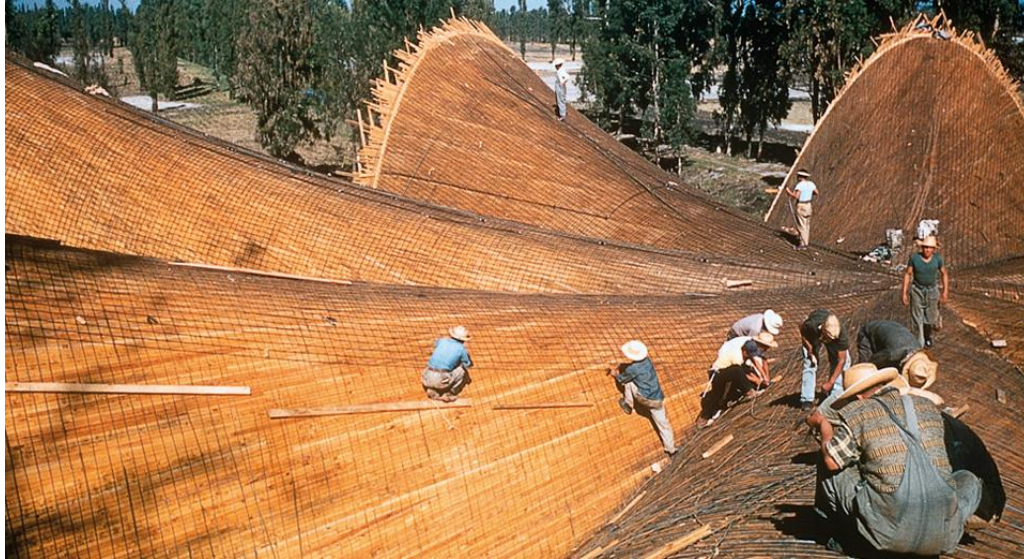
Figura 95: Colocação de armaduras sob a cofragem reta de madeira no restaurante Los Manantiales [54].
