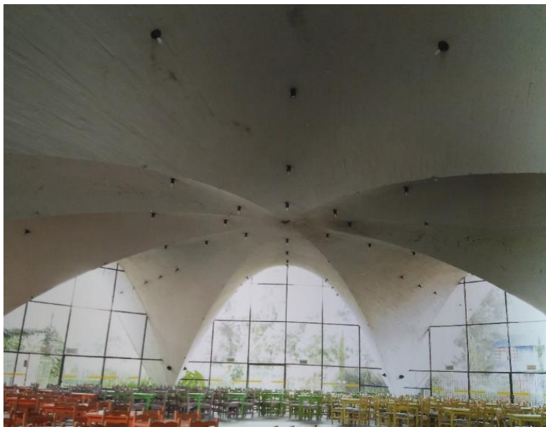
Figura 93: Destaque das nervuras vistas do interior do restaurante Los Manantiales (adaptado de [2])
