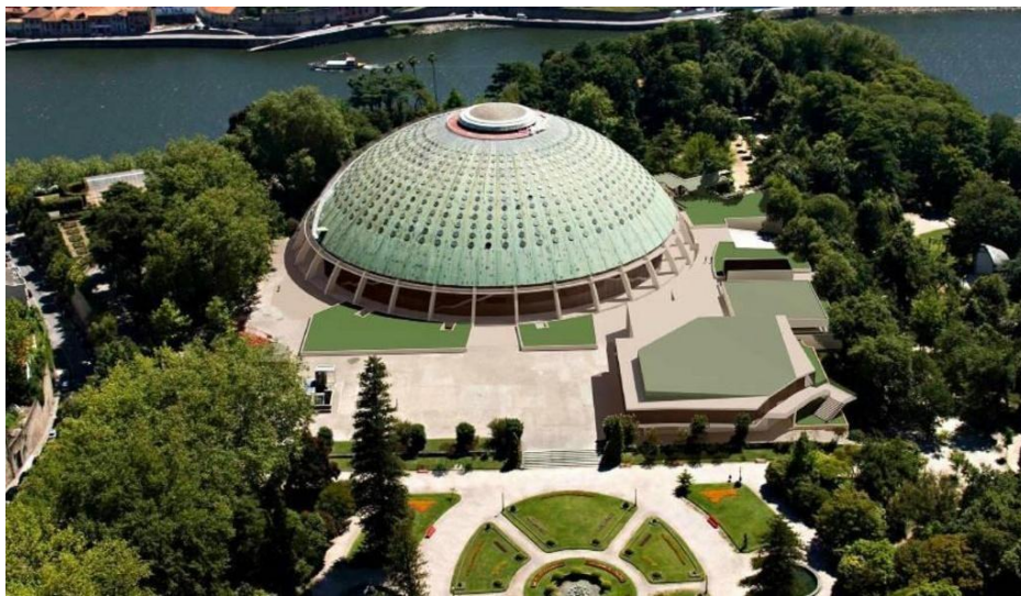
Figura 15: Pavilhão Rosa Mota [18].
