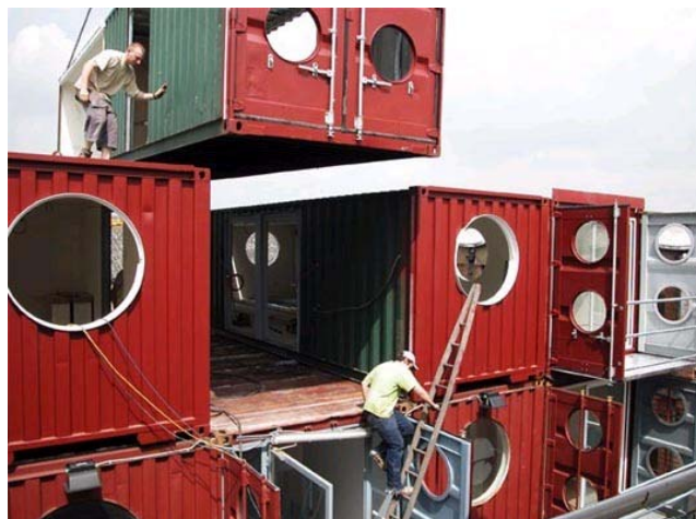
Figura 41 – Colocação de contentores remodelados nas suas posições finais [F38]
