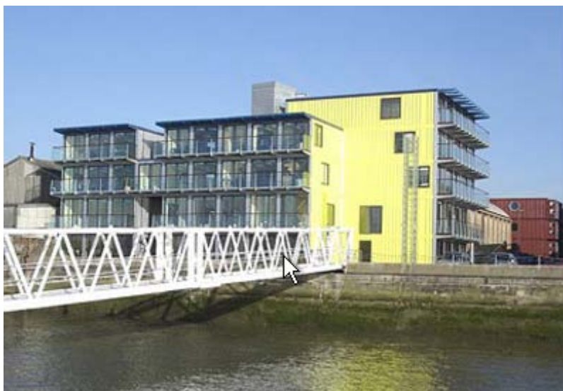
Figura 12 – Edifícios de escritórios frente ao rio Tamisa (Londres) [F9]
