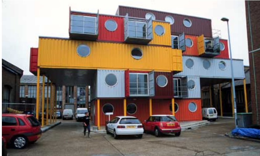
Figura 14 – Edifício de habitação e escritórios nas docas de Londres [F11]
