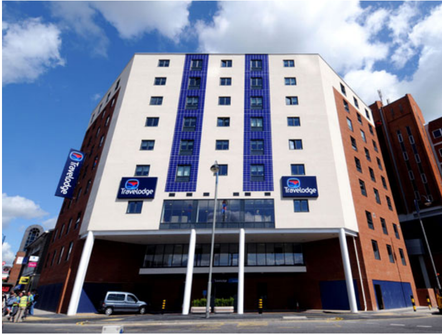
Figura 18 – Hotel em Uxbridge, Inglaterra (obra acabada) [F14]
