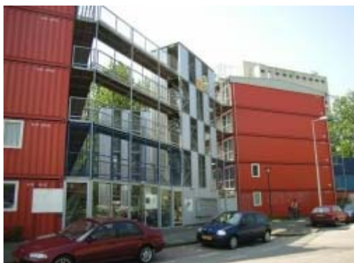
Figura 49 – Complexo de edifícios desmontáveis (Holanda) [F45]
