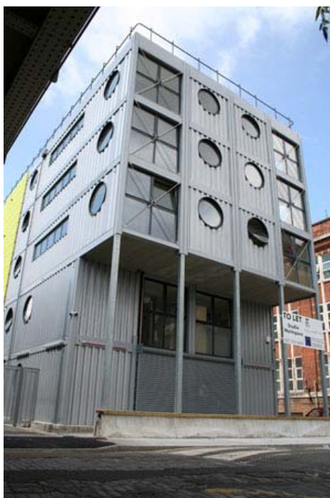
Figura 13 – Edifício de T0's e pequenos ateliês nas docas de Londres [F10]
