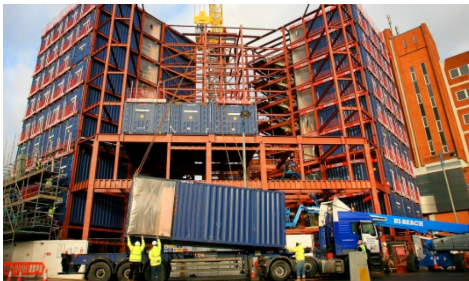
Figura 17 – Hotel em Uxbridge, Inglaterra (fase construtiva) [F14]
