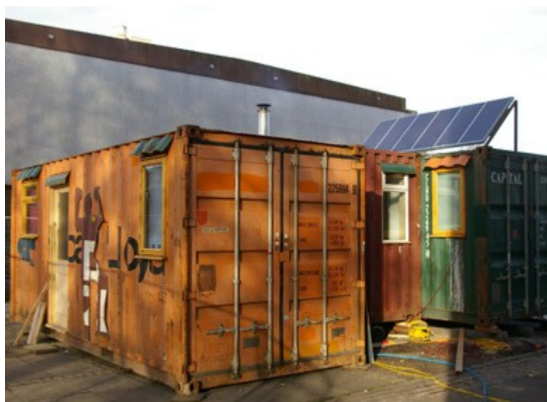
Figura 11 – Contentores marítimos remodelados em estaleiro de obra (Portugal) [F8]
