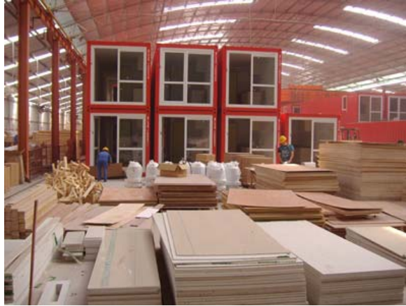
Figura 40 – Zona de montagem – nave industrial [F37]
