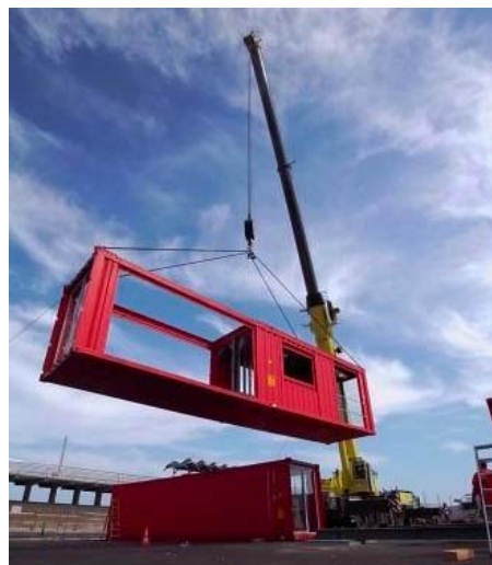
Figura 43 – Grua móvel manuseando um contentor marítimo remodelado [F40]
