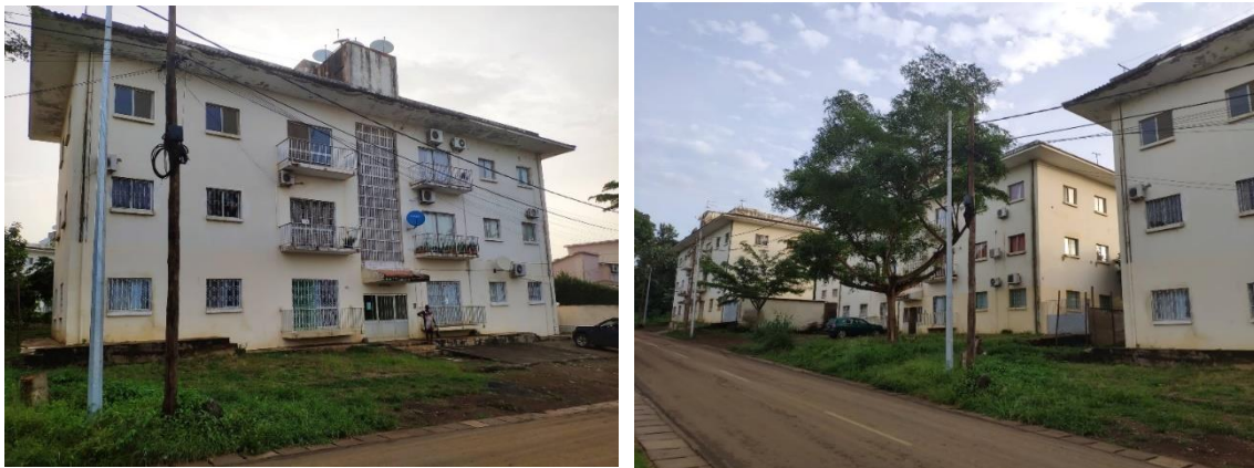
Figura 35 - Fotos dos prédios do Campo de Milho, (Patrícia dos Anjos, 2019)
