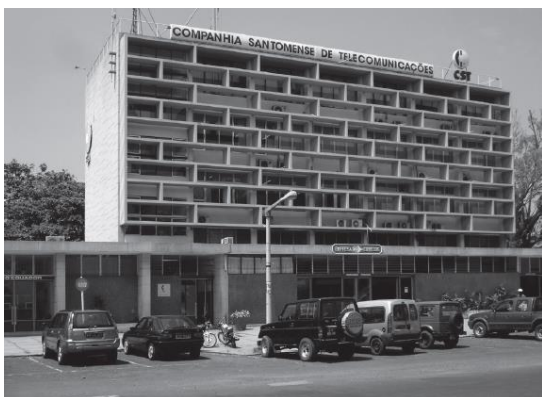
Figura 13 - Edifício da CST na marginal, (foto de Isabel Godinho)
