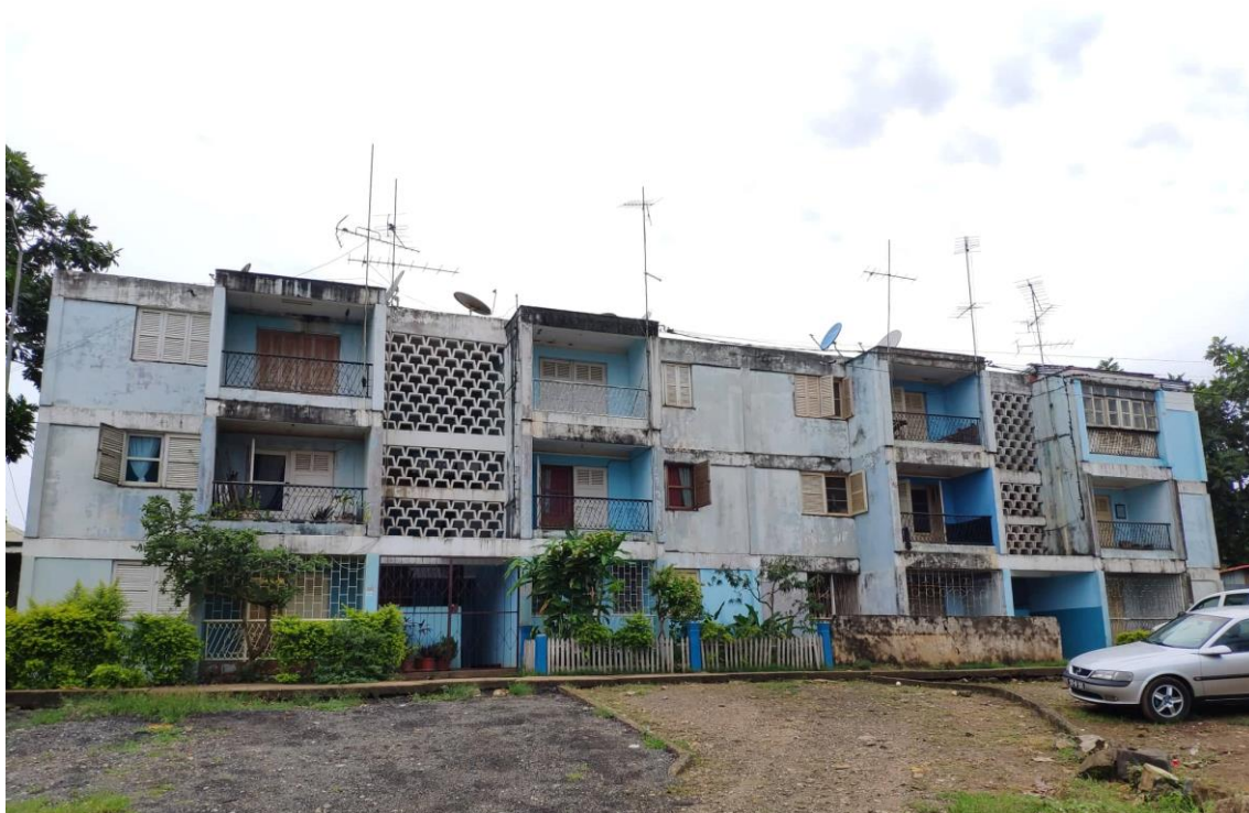
Figura 39 - Foto do Prédio do bairro do Riboque, (Patrícia dos Anjos, 2019)
