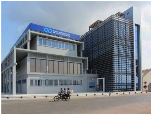
Figura 19 - Edifício do BISTP, (Patrícia dos Anjos, 2019)
