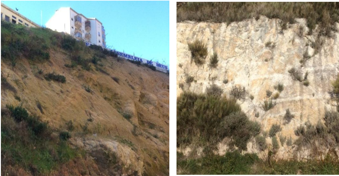
Figura A6. Exemplos de taludes de solos residuais de granito na Covilhã.
