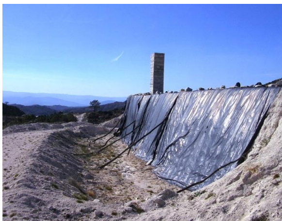
Figura A10. Vista de um dos alçados do aterro pouco tempo depois da sua construção.
