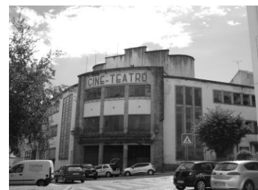
Figura 48 - Cineteatro Guarda, Fachada Imagem do autor, Agosto 2014
