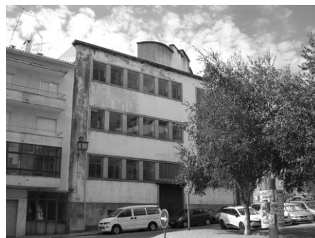
Figura 65 - Fachada Principal, acesso rua Dr. Francisco dos Prazeres Imagem do autor, Agosto 2014
