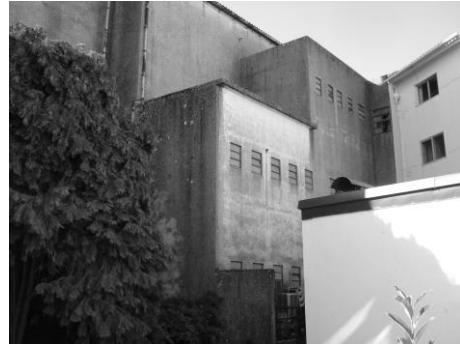
Figura 63 - Fachada lateral direita Imagem do autor, Agosto 2014
