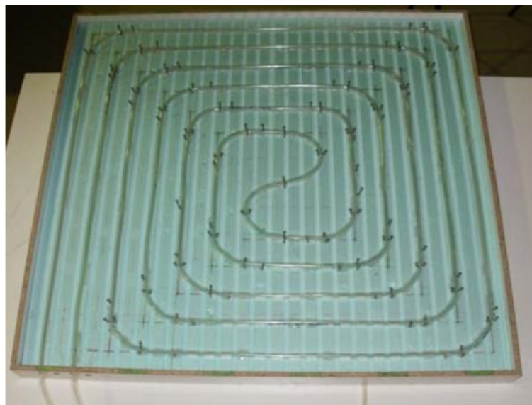
Figura 5.9: Colocação do isolamento e fixação da tubagem [55].
