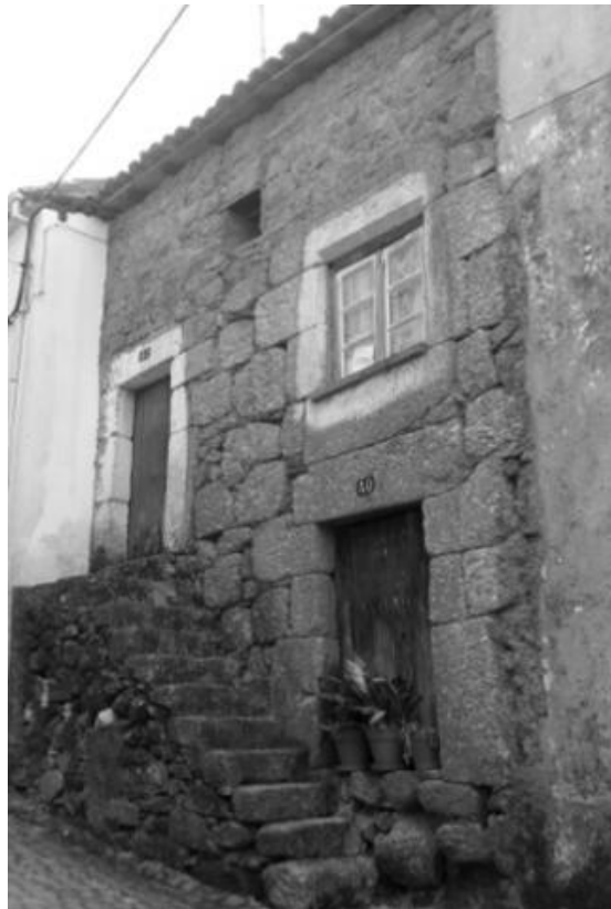
Figura 29 - Casa de Cortes do Meio (Fonte: Autoria Própria, 2018)
