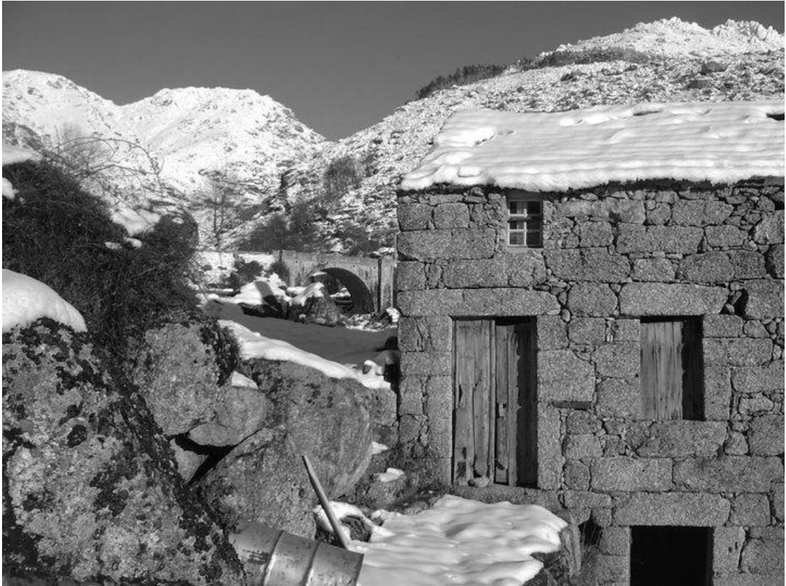
Figura 11 - Habitação na Serra da Estrela (Fonte: Museu Virtual de Manteigas; Autor: Desconhecido, s.d.)
